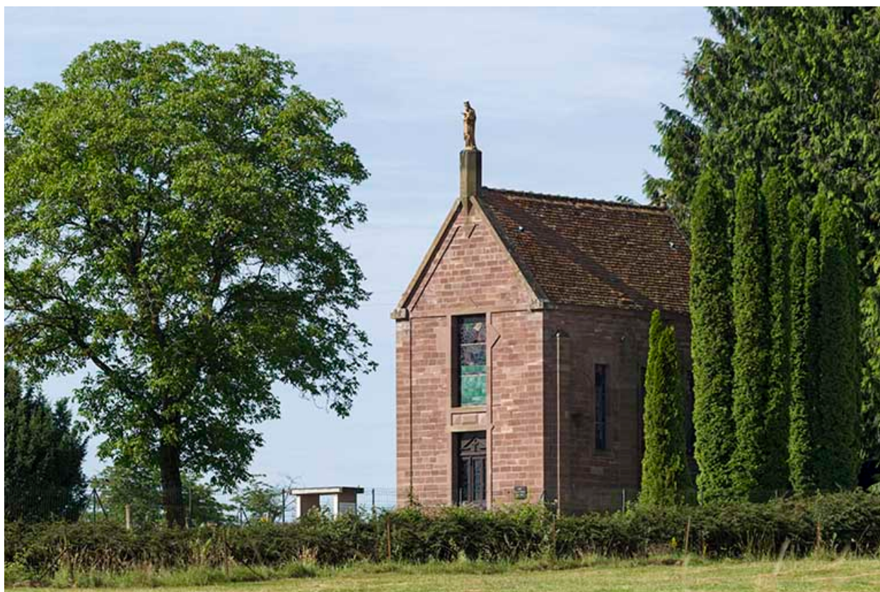
Façade principale de la chapelle.
