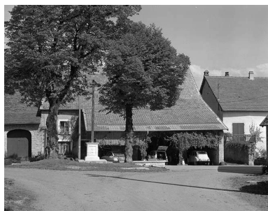
Façade antérieure vue de face en 1981.
