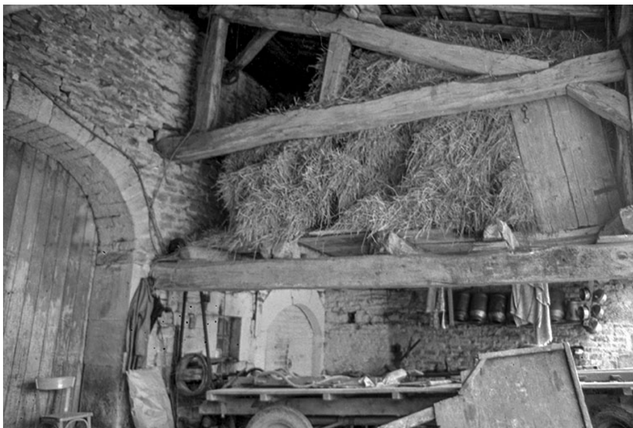
Détail de la charpente en 1974.
