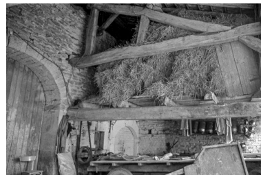
Détail de la charpente en 1974.
