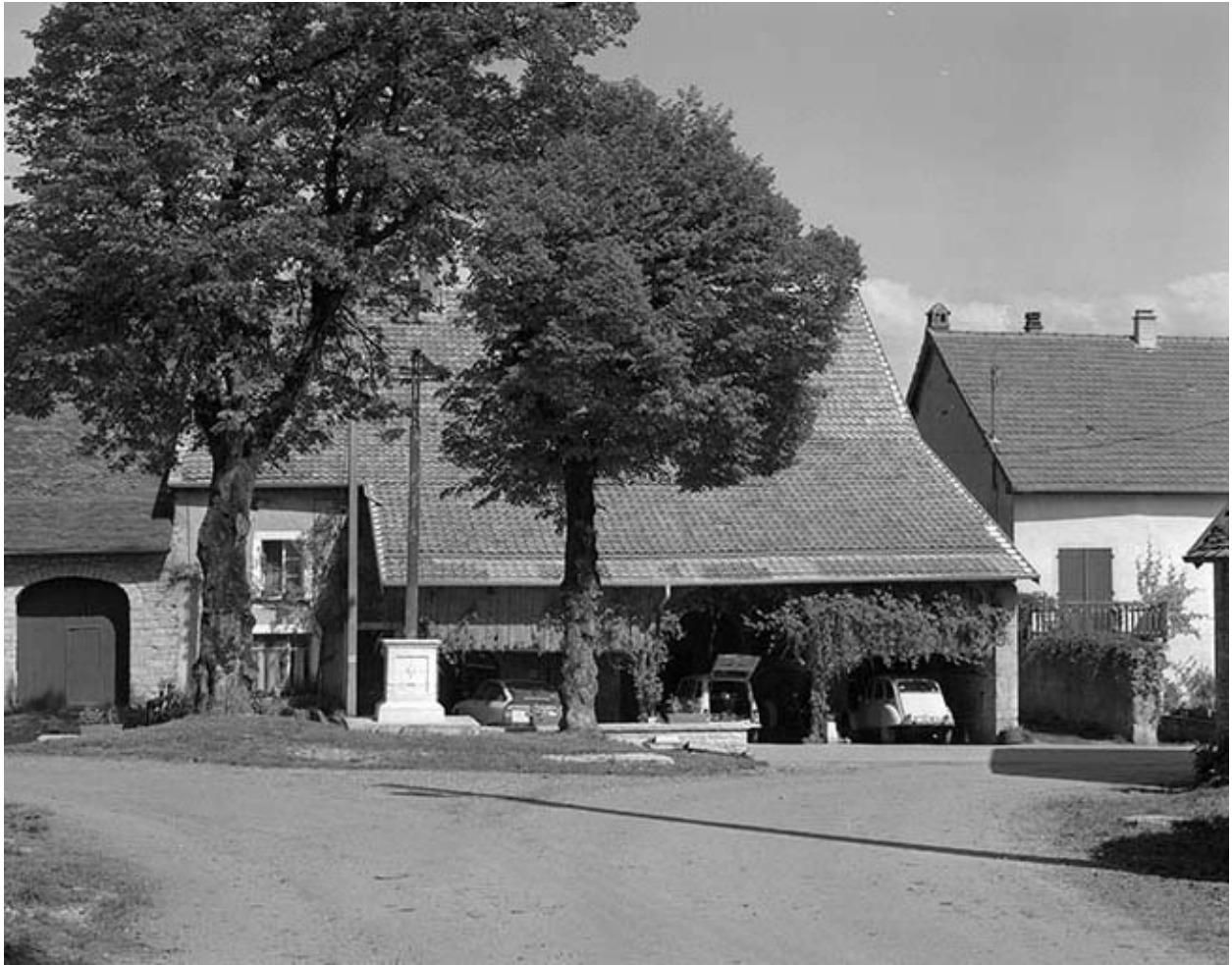
Façade antérieure vue de face en 1981.
