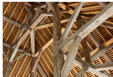
Croupe du séchoir. Partie supérieure de la charpente. Phot. Jérôme Mongreville IVR43_20162501142NUC4A
