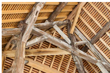
Détail de la charpente de la croupe. Phot. Jérôme Mongreville IVR43_20162501143NUC4A
