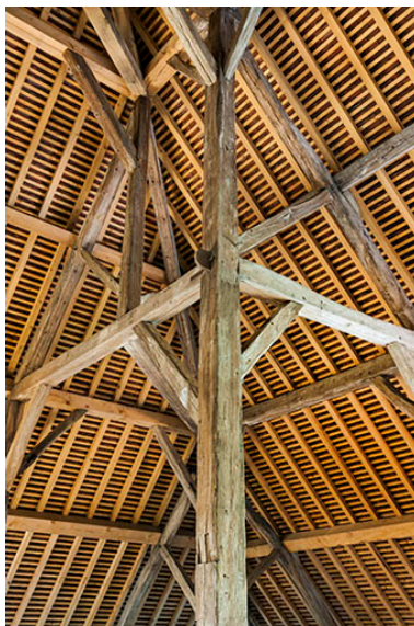
Charpente du séchoir. Détail de la croupe. Phot. Jérôme Mongreville IVR43_20162501141NUC4A
