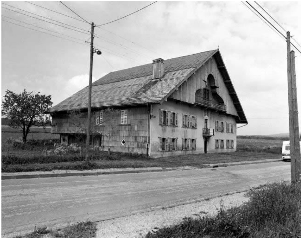
Ferme située rue Condemine.
