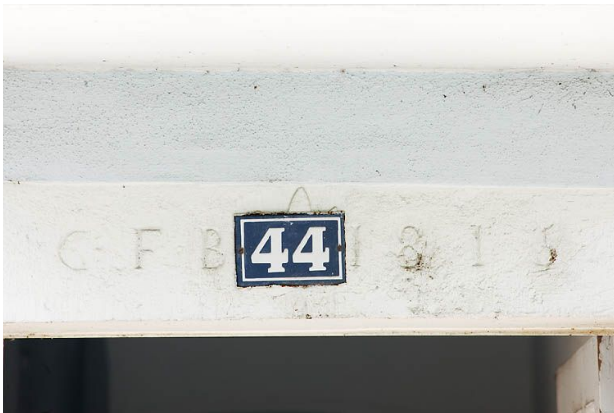
Détail du linteau de porte.
