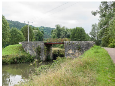
Vue du pont.
