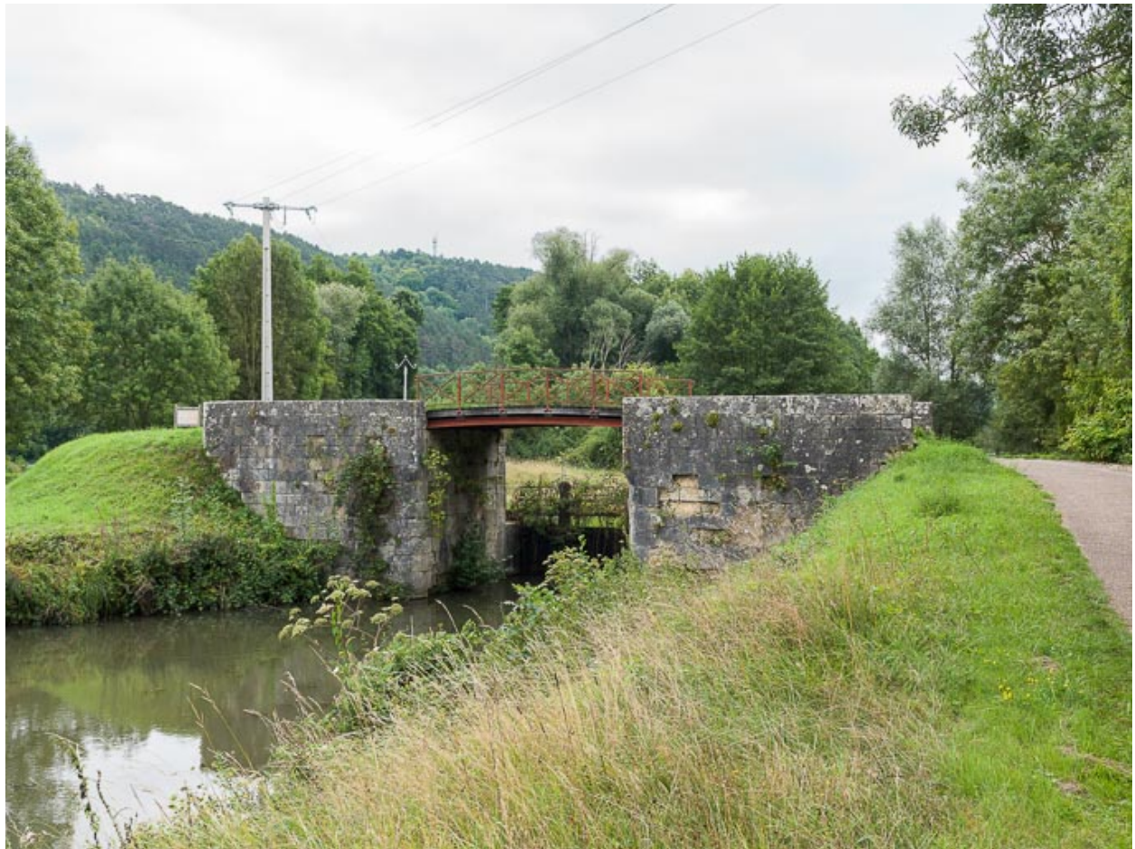
Vue du pont.
