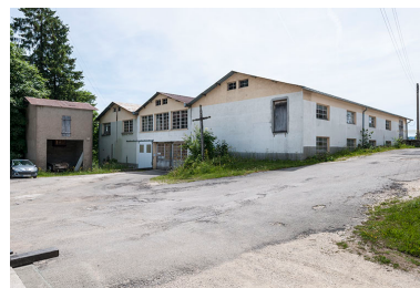
Extensions postérieures de l'atelier de menuiserie. Phot. Jérôme Mongreville IVR43_20152501602NUC4A
