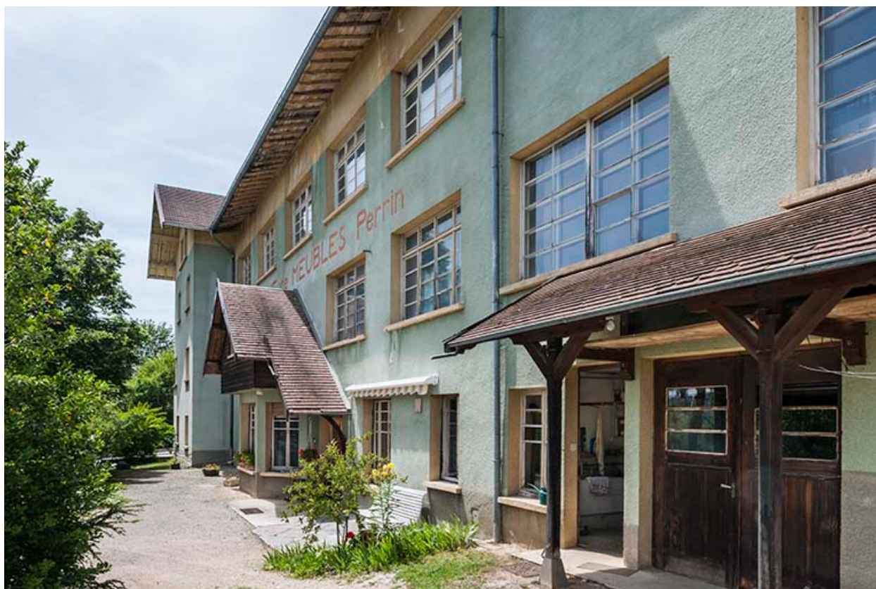
Détail de la façade est.
