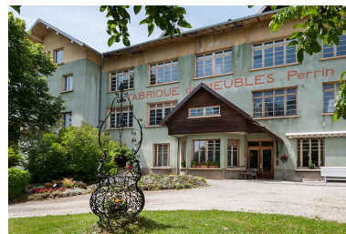
Atelier de menuiserie. Façade est. Phot. Jérôme Mongreville IVR43_20152501600NUC4A
