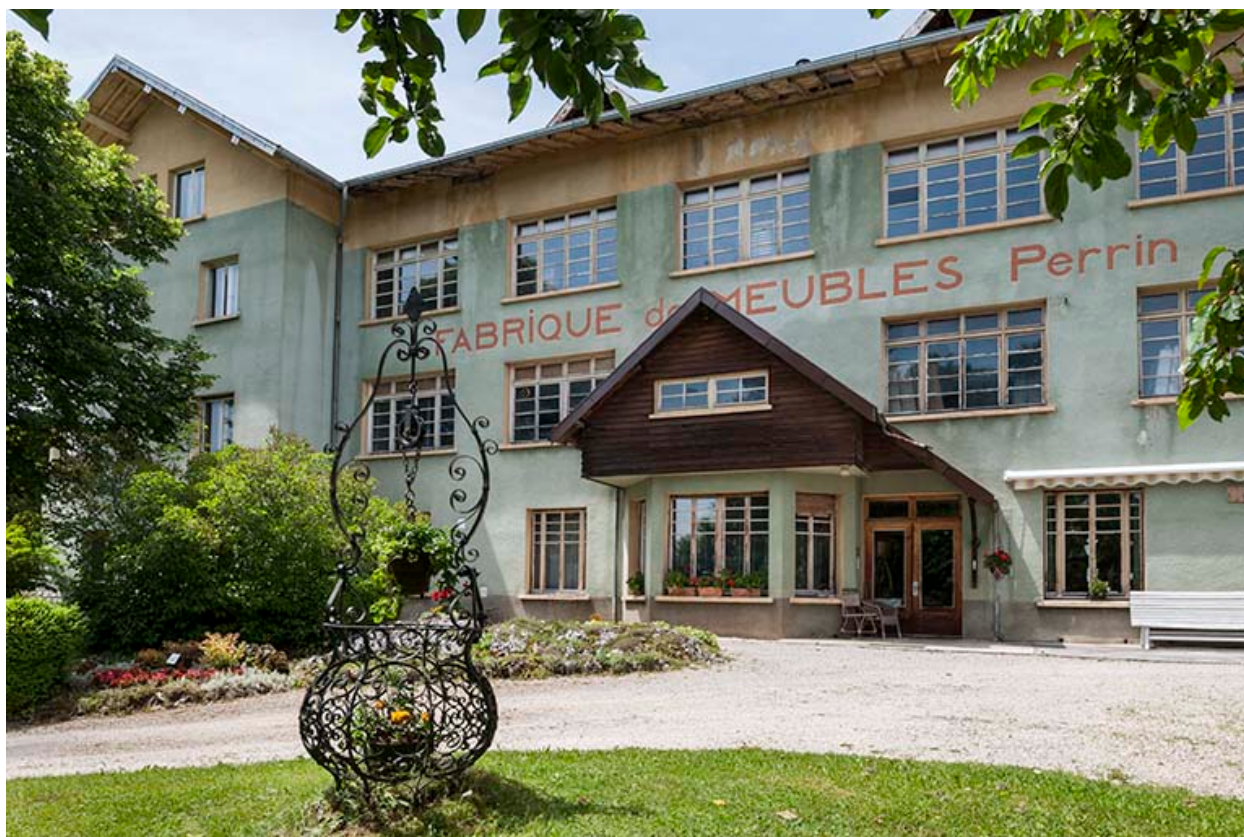
Atelier de menuiserie. Façade est.
