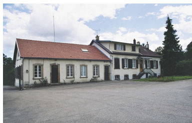
Les bureaux attenants au logement de contremaître. Phot. Yves Sancey IVR43_20009000180ZA
