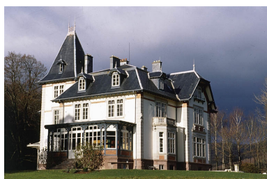
Le logement patronal depuis l'est. Phot. Jérôme Mongreville IVR43_20019000537ZA
