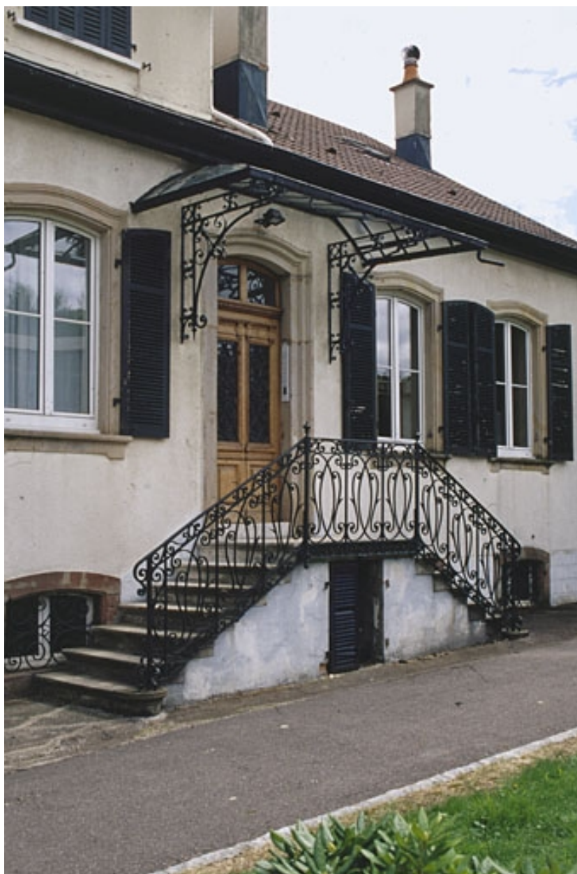
Le perron du logement de contremaître.
