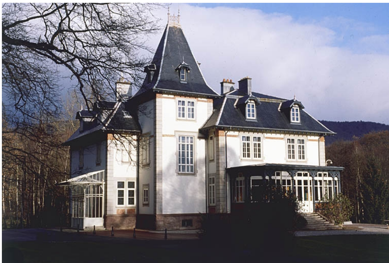
Façades sud du logement patronal.
