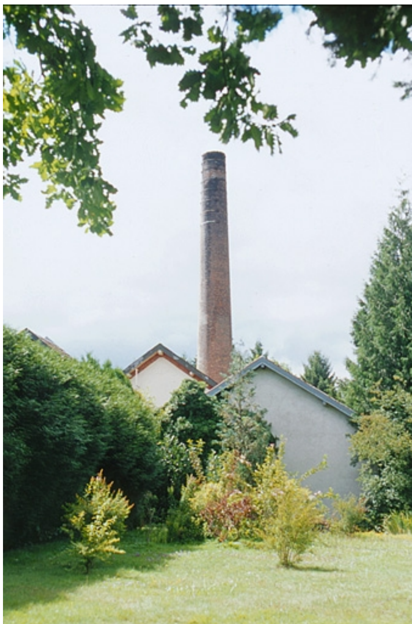
Pignons des ateliers de fabrication et cheminée.
