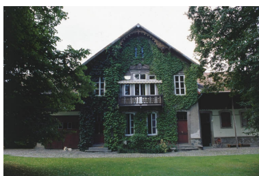
Mur-pignon du logement de la ferme. Phot. Yves Sancey IVR43_20009000201ZA
