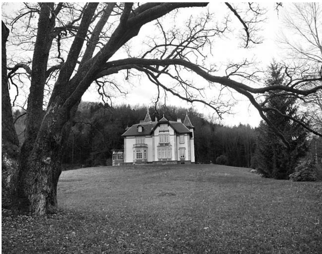
Vue d'ensemble du logement patronal.
