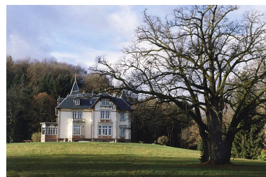
Le logement patronal depuis le nord-est. Phot. Jérôme Mongreville IVR43_20019000535ZA
