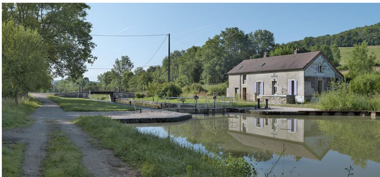
Site d'écluse vu d'amont.
