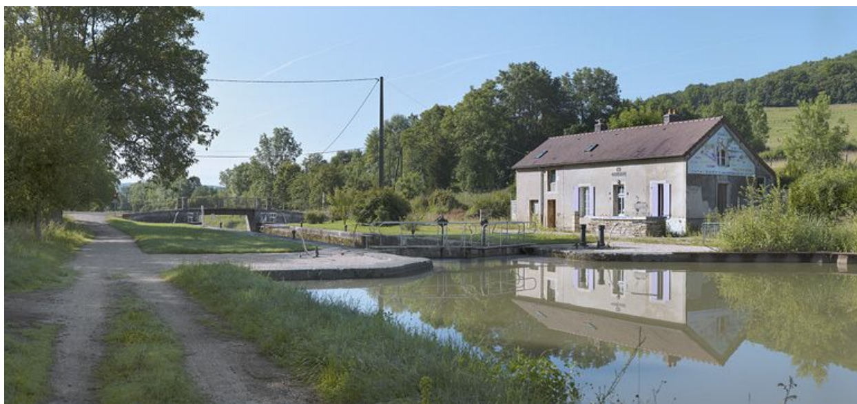
Site d'écluse vu d'amont.
