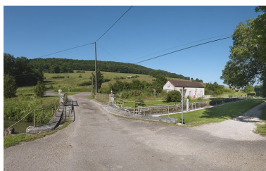
Site d'écluse vu d'aval. Phot. Thierry Kuntz IVR26_20122102214NUC4A
