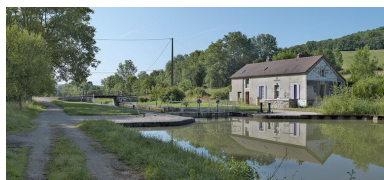
Site d'écluse vu d'amont. Phot. Thierry Kuntz IVR26_20122102211NUC4A
