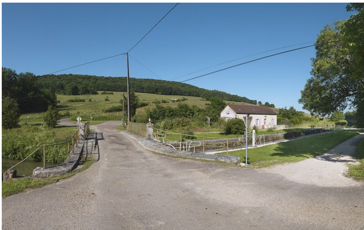
Site d'écluse vu d'aval.
