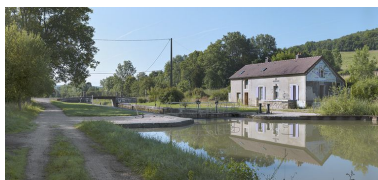
Site d'écluse vu d'amont. Phot. Thierry Kuntz IVR26_20122102212NUC4A
