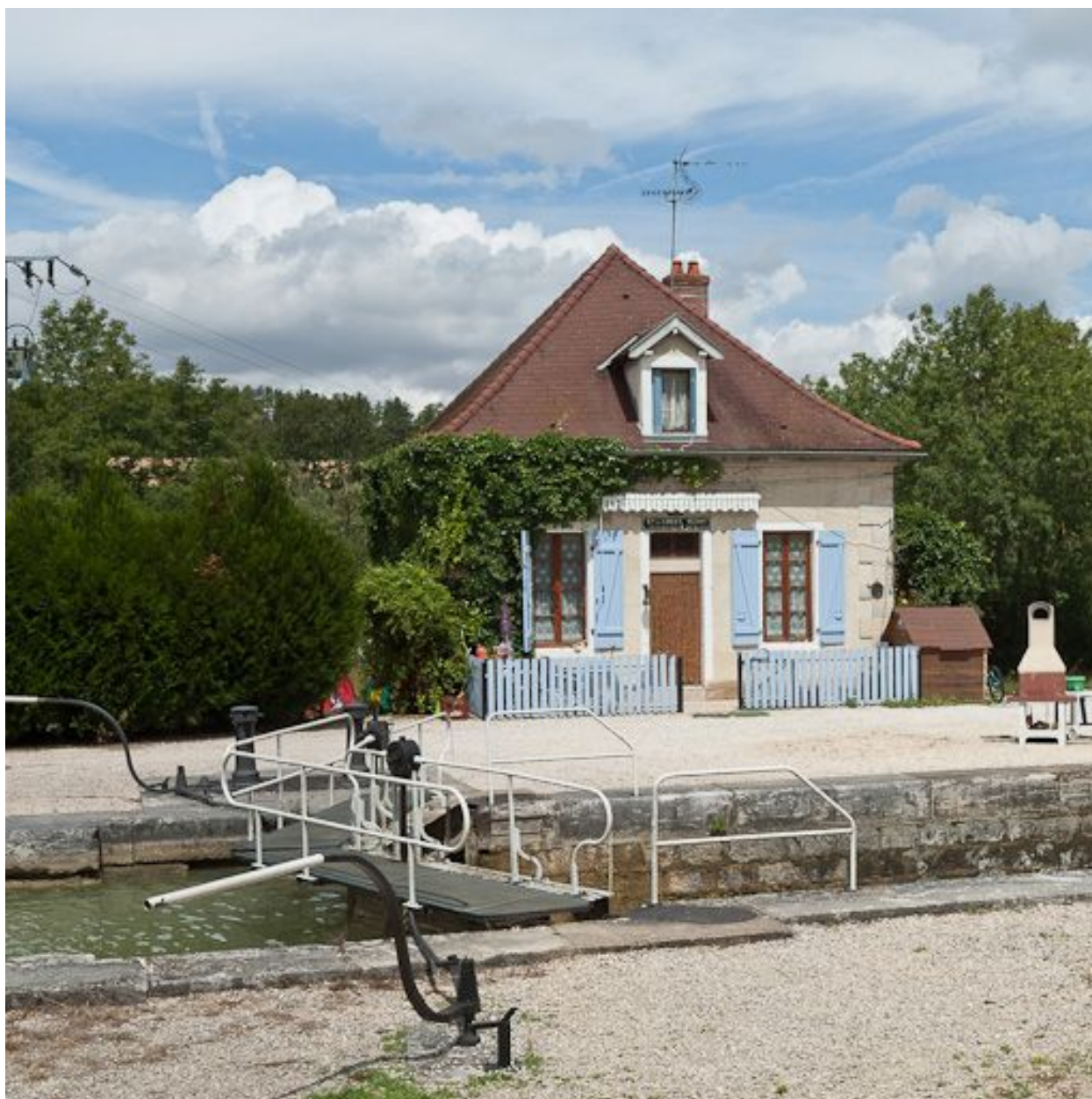
Vue de la maison éclusière.
