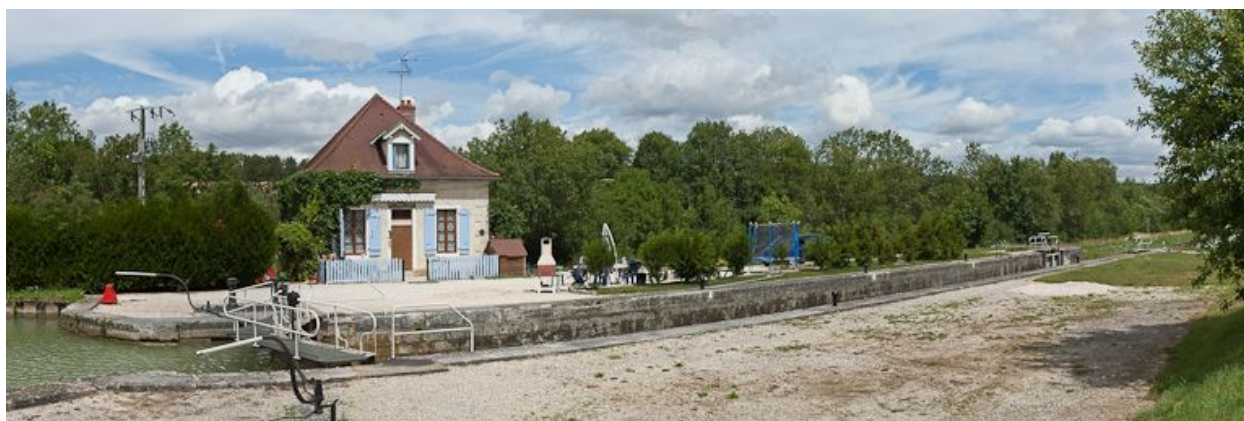
Vue d'ensemble du site d'écluse.
