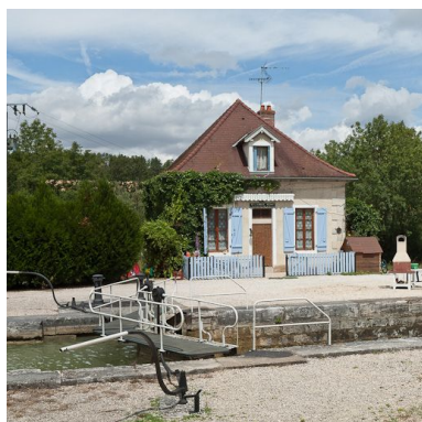
Vue de la maison éclusière. Phot. Pierre-Marie Barbe-Richaud IVR26_20112103569NUC2AQ
