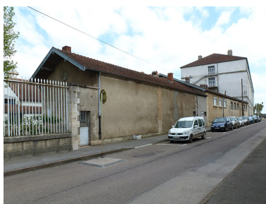
Façades et entrée sud- ouest sur la rue Signard. Phot. Mary Ruffinoni IVR43_20157000084NUC4A
