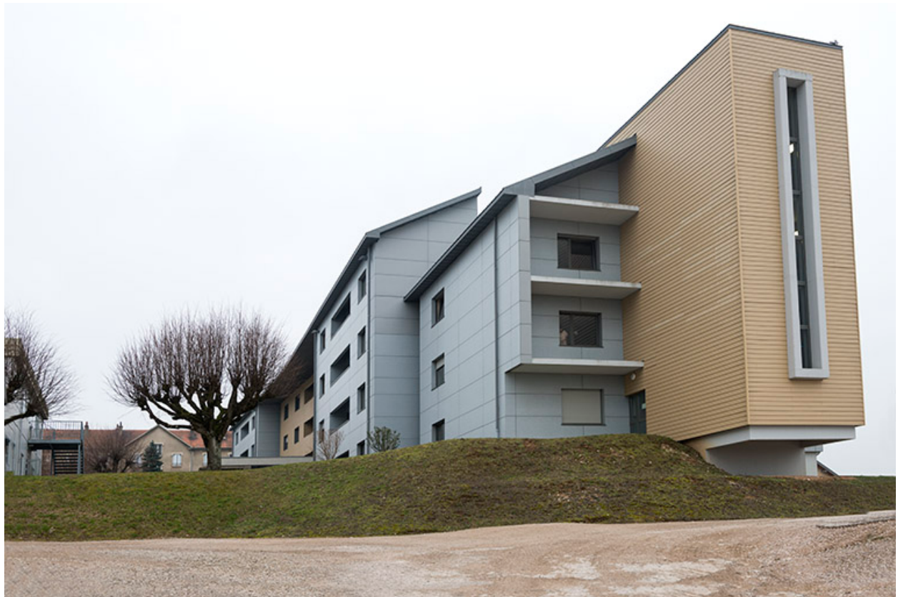
Pignon sud et vue de trois-quart de la façade antérieure sur cour de l'internat de garçons.
