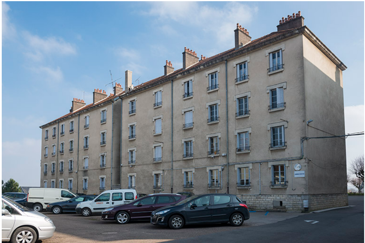
Façade postérieure nord-ouest des logements et administration.
