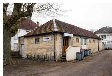
Angle sud-est de l'ancien corps de garde.
