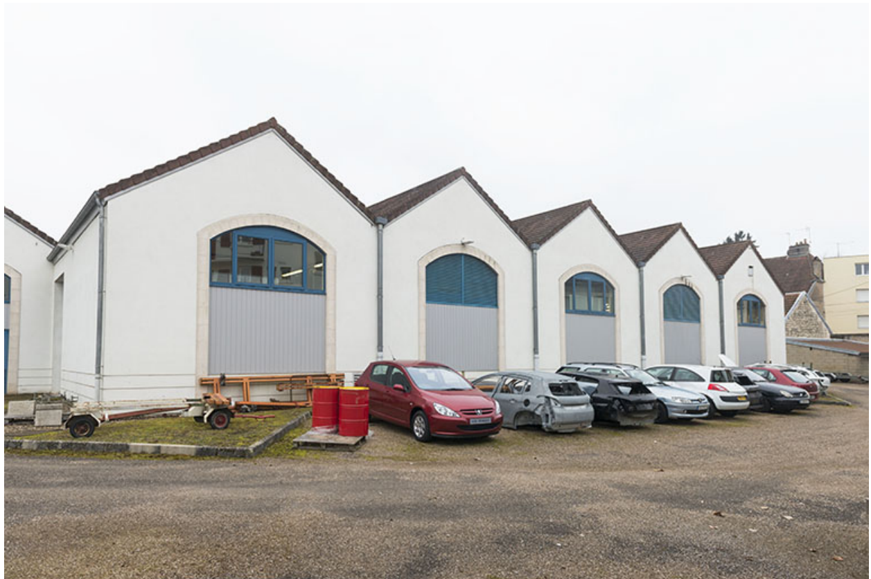
Les pignons nord-ouest des ateliers.
