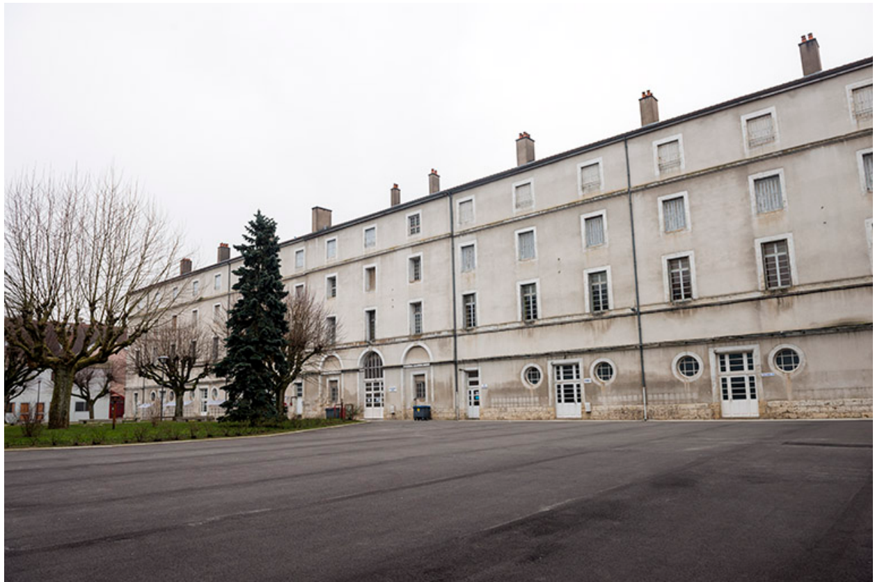
Cour, façade postérieure nord-est de l'ancienne caserne.
