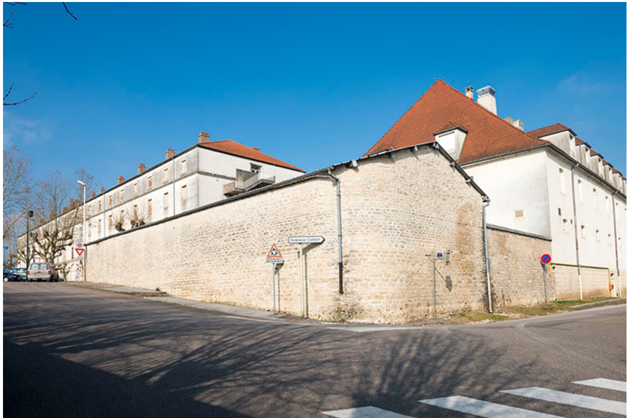
Angle sud-est de l'ancienne caserne.
