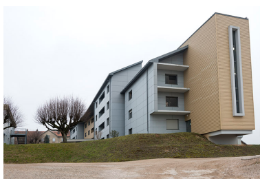
Pignon sud et vue de trois- quart de la façade antérieure sur cour de l'internat de garçons. Phot. Mary Ruffinoni IVR43_20157000049NUC4A
