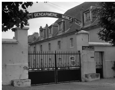
Partie droite de l'ancienne caserne : ancien manège.
