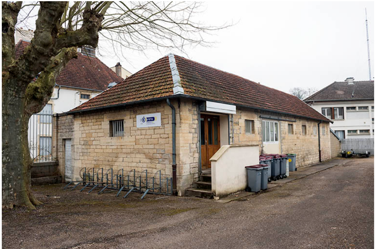
Angle sud-est de l'ancien corps de garde.
