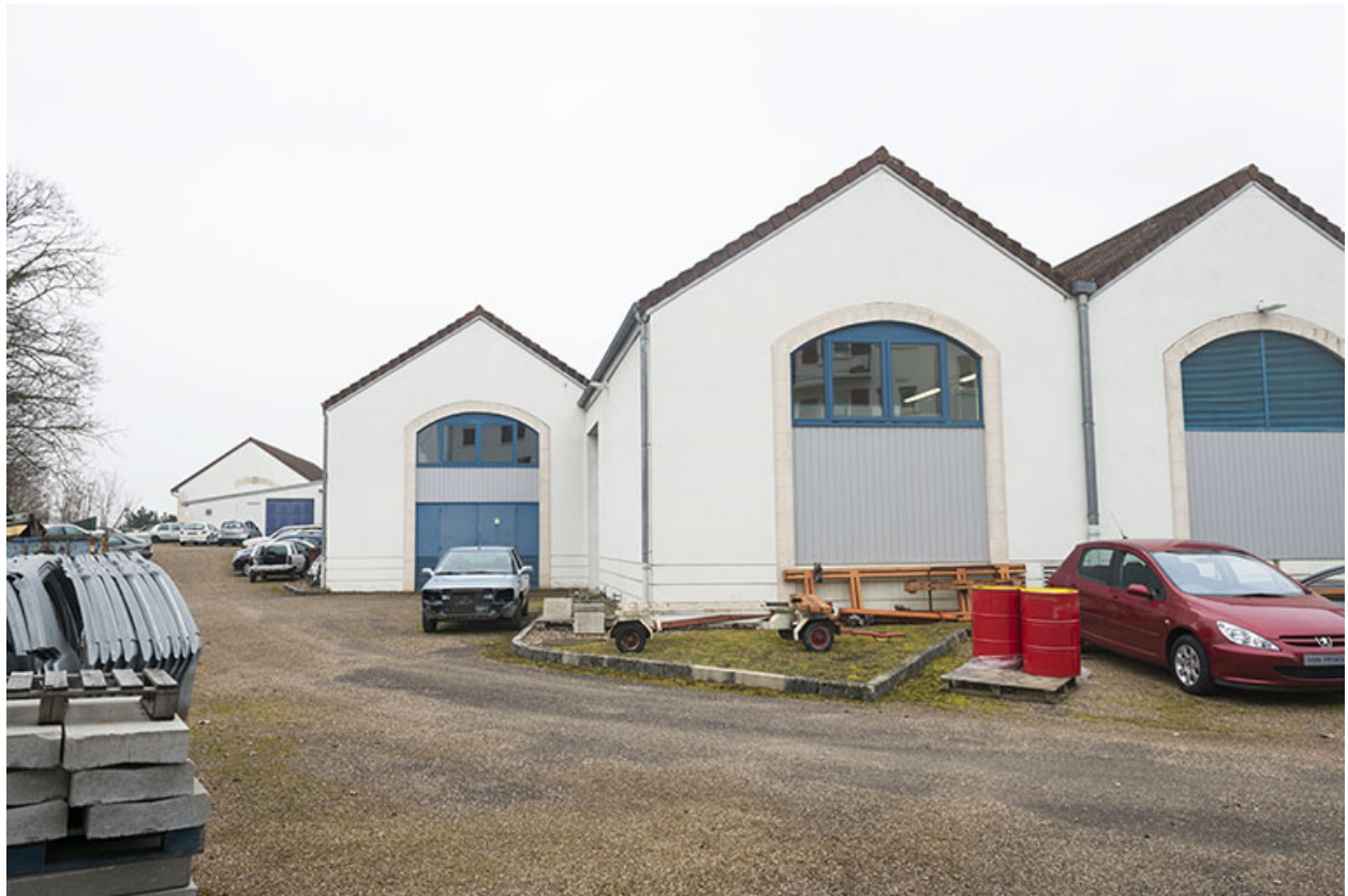
Angle nord-est des ateliers.
