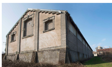
"Au bas de la caserne,\" vue de trois quart sud-est du pignon postérieur du gymnase, ancien manège Colbert. Phot. Mary Ruffinoni IVR43_20157000078NUC4A
