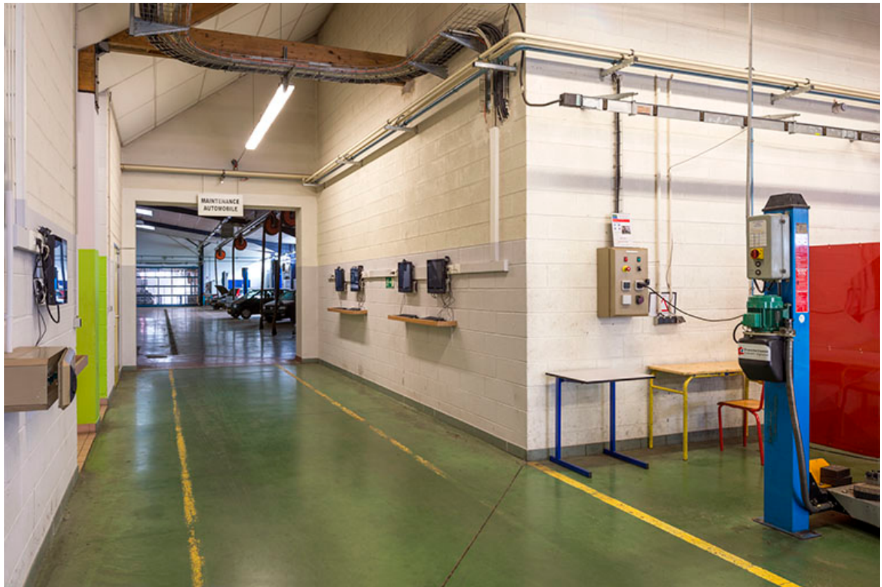
Vue intérieure de l'atelier mécanique auto.
