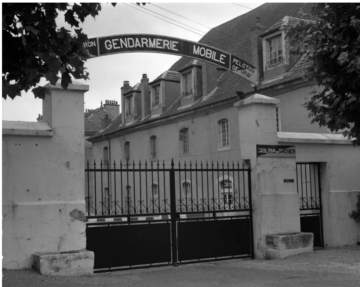
Partie droite de l'ancienne caserne : ancien manège.
