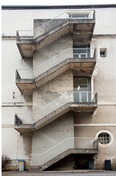
Pignon sud-est de l'ancienne caserne.
