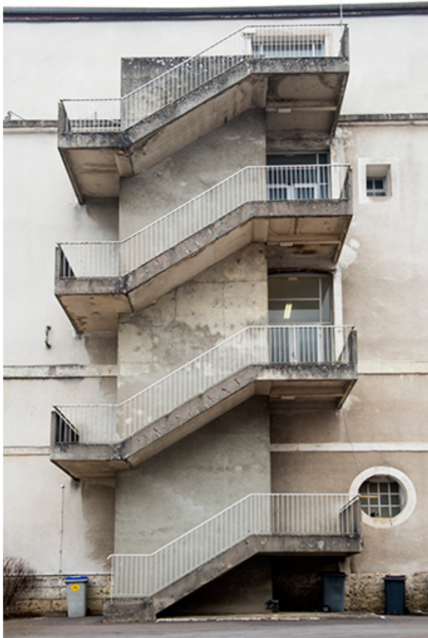
Pignon sud-est de l'ancienne caserne.
