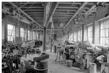
Intérieur de l'atelier de fabrication.
