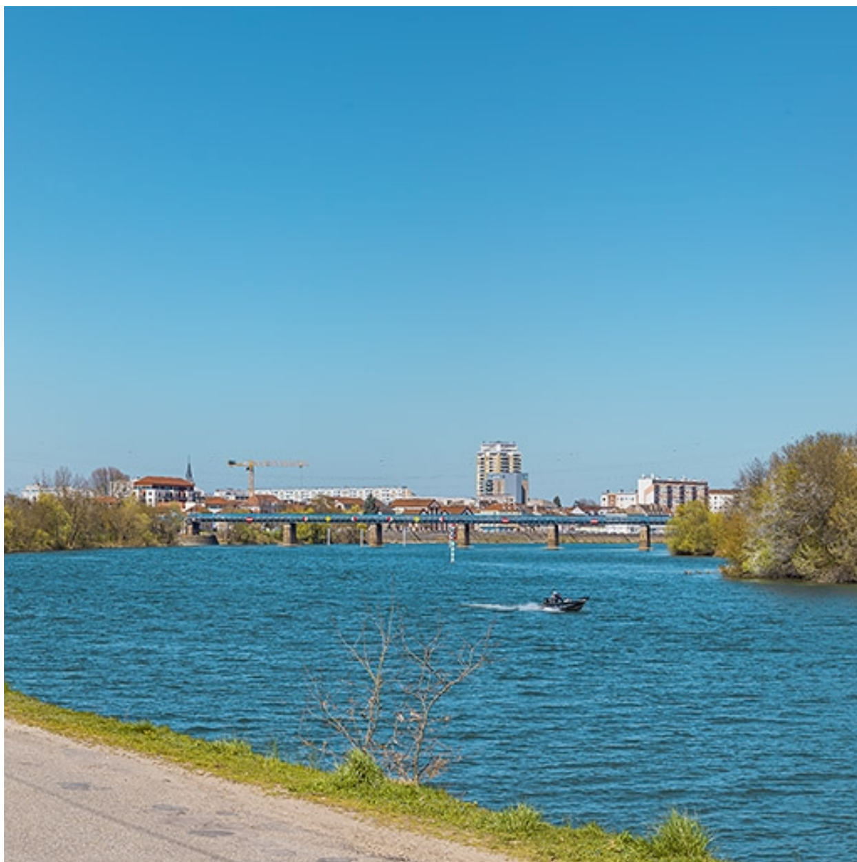
Vue d'ensemble du pont, depuis l'aval.
