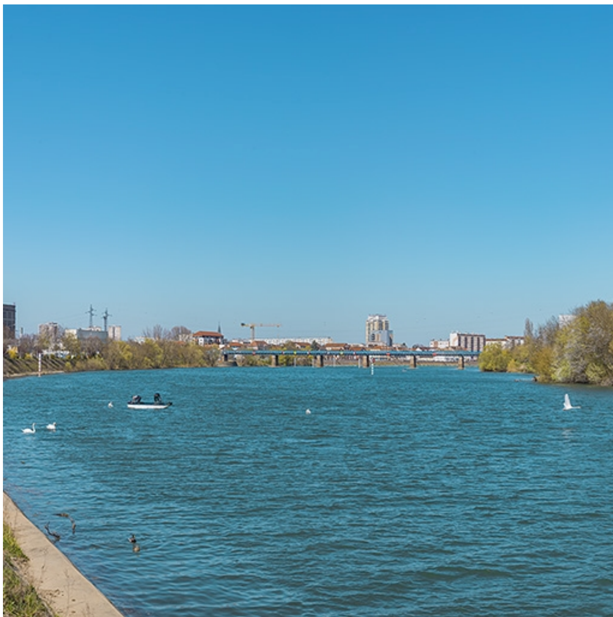
Vue d'ensemble du pont, depuis l'aval.
