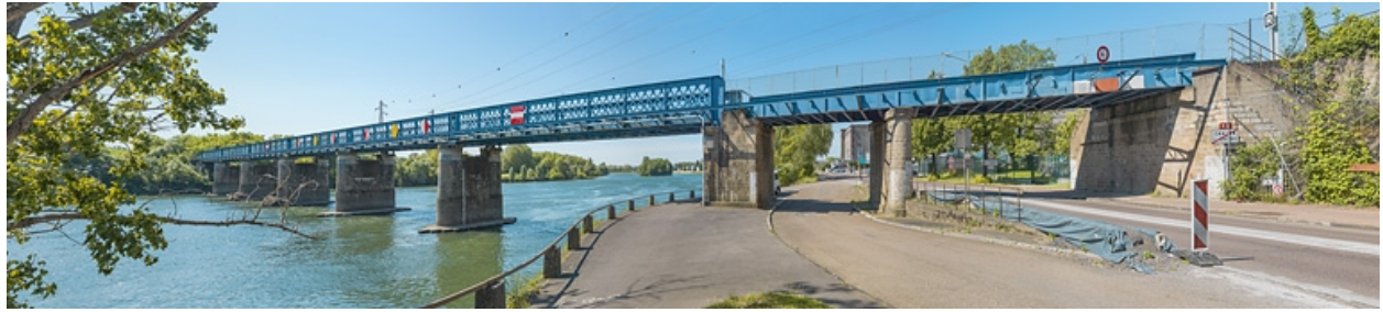
Le viaduc vu d'amont.
