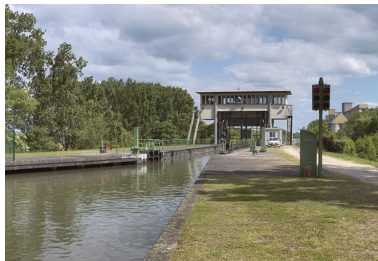
Vue d'amont. Phot. Thierry Kuntz IVR26_20137100288NUC4A
