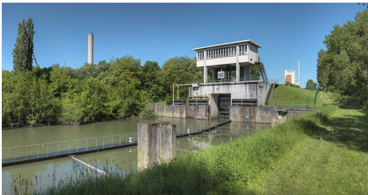
Vue d'ensemble d'aval.
