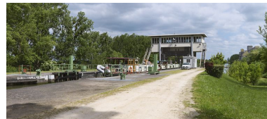
Vue d'amont. Phot. Thierry Kuntz IVR26_20137100286NUC4A
