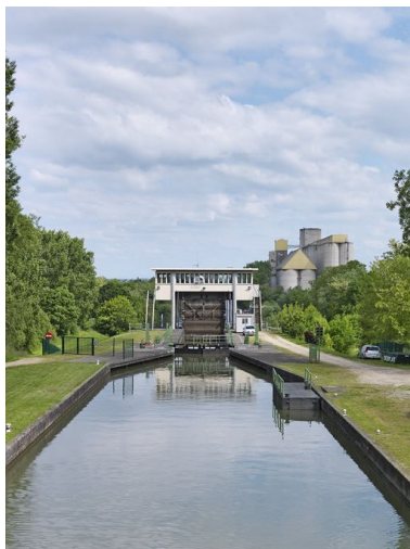
Vue d'amont. Phot. Thierry Kuntz IVR26_20137100296NUC4A
