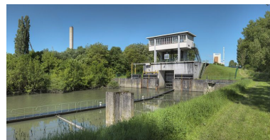
Vue d'ensemble d'aval. Phot. Thierry Kuntz IVR26_20137100279NUC4A
