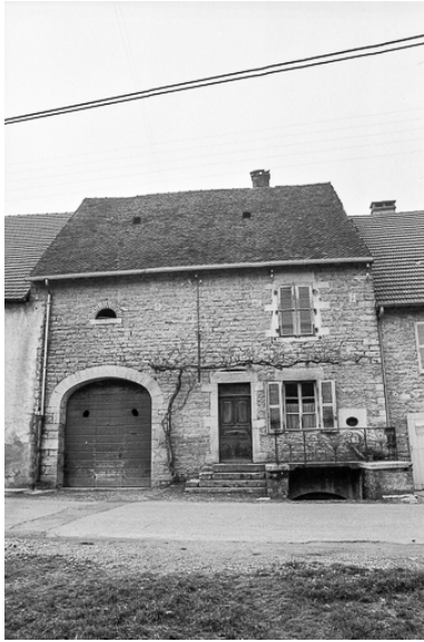
Façade antérieure en 1974. Phot. F. Pernin IVR43_19743900033Z
