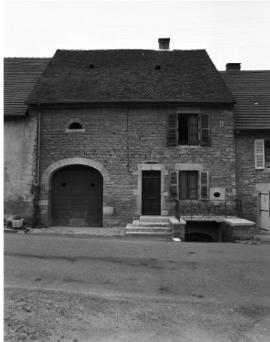
Façade antérieure en 1981. Phot. Yves Sancey IVR43_19813900209X
