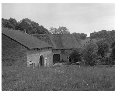
Ferme située au lieudit Chez les Basset : façade antérieure. Phot. Yves Sancey IVR43_19813900147X
