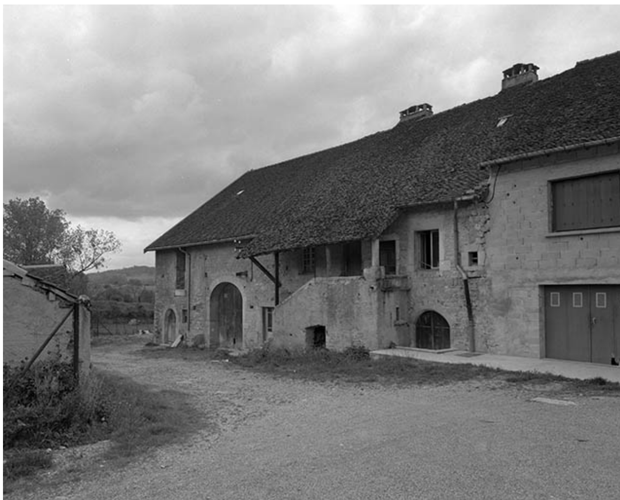
Ferme située rue du Tour : façade antérieure.
