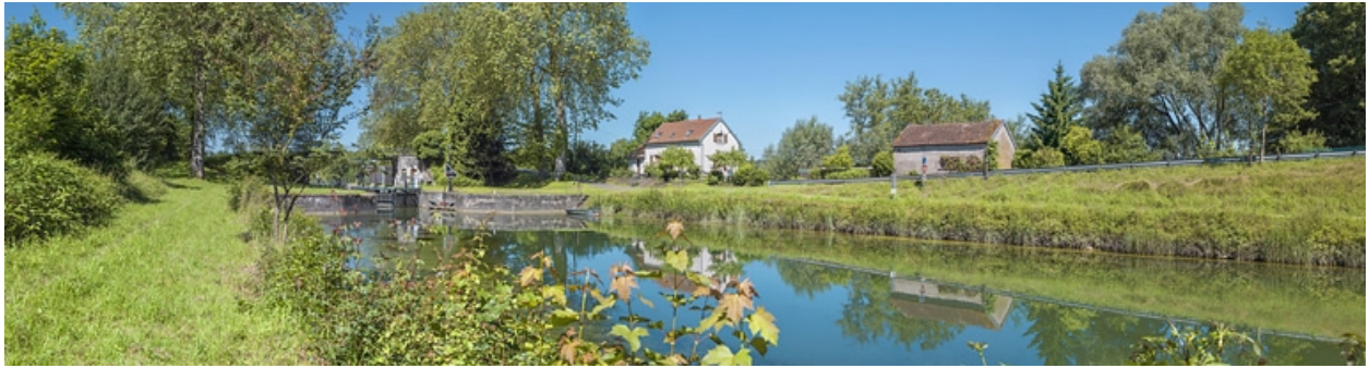
Vue d'amont. Maison éclusière à droite.
