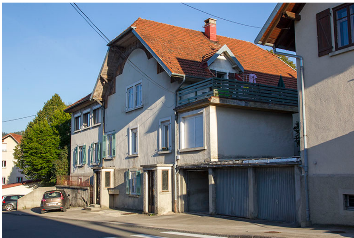
Maison : façade antérieure, vue en enfilade.
