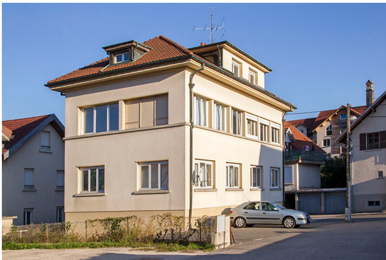
Usine : façades postérieure et latérale gauche.
