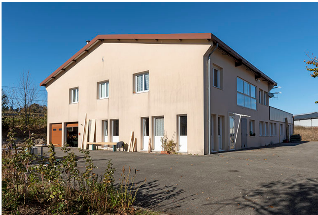
Façades antérieure et latérale gauche.
