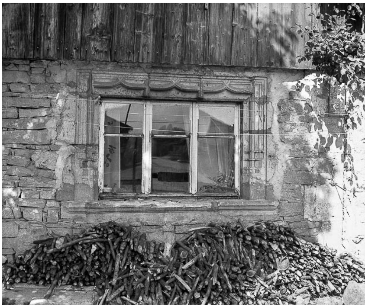
Façade antérieure : fenêtre.
