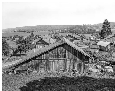
Façade postérieure. Phot. Yves Sancey IVR43_19762500737V
