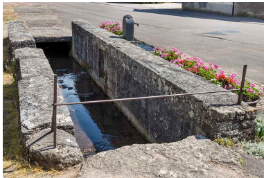
Le ruisseau canalisé alimentant les bornes fontaines.
