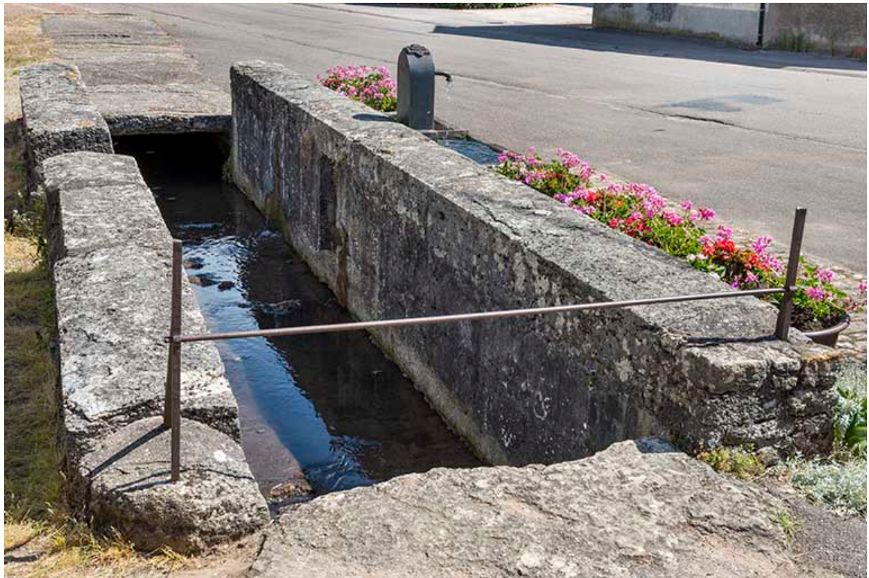
Le ruisseau canalisé alimentant les bornes fontaines.
