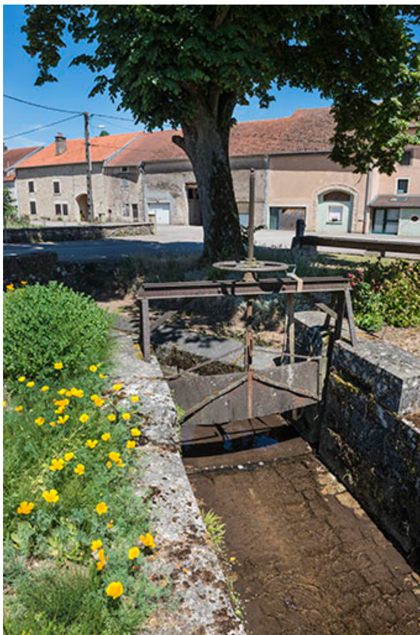
Vanne située à l'extrémité sud du village.
