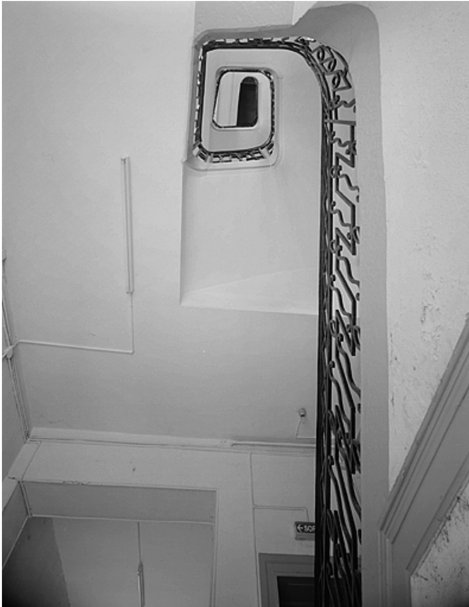
Vue d'ensemble de l'escalier.
