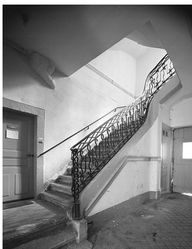
Escalier vu au rez-de-chaussée. Phot. Jérôme Mongreville IVR43_19872501206V
