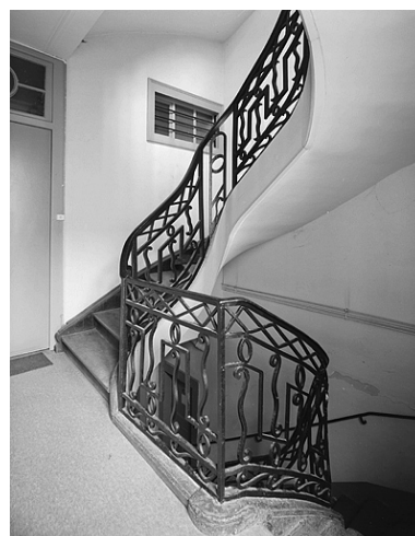
Escalier vu du palier du premier étage. Jusqu'au premier, la rampe d'appui est en métal. Pour la volée conduisant au deuxième, le même dessin est réalisé en bois. Phot. Jérôme Mongreville IVR43_19872501207V
