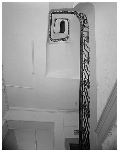
Vue d'ensemble de l'escalier. Phot. Jérôme Mongreville IVR43_19872501208V
