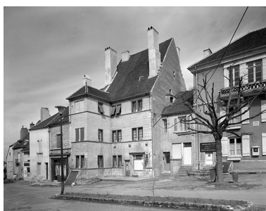
Maison située 3 Grande Rue : vue d'ensemble. Phot. Yves Sancey IVR43_19857000035V
