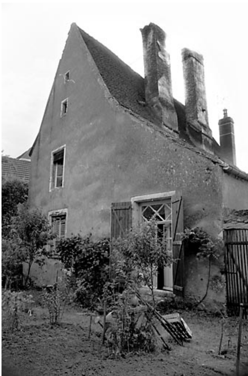
Maison située rue Sainte-Anne : vue d'ensemble.
