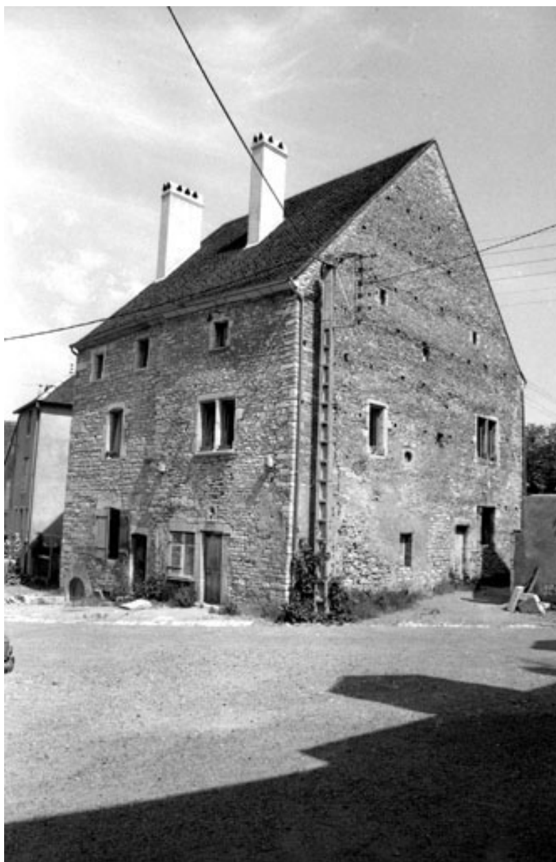
Maison située 16 rue Saint-Hilaire : vue d'ensemble.
