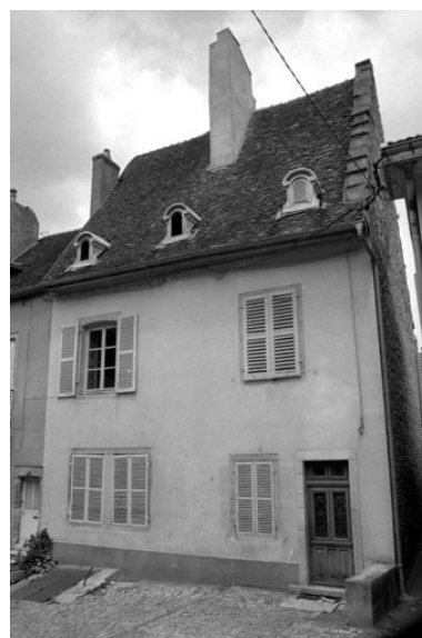
Maison située ruelle Saint- Jacques : façade antérieure donnant sur la rue Saint-Hilaire. Phot. Bernard Lardière IVR43_19817000793Z
