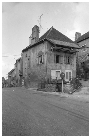
Maison située 18 rue Vanoise : vue d'ensemble. Phot. Bernard Lardière IVR43_19817000845Z
