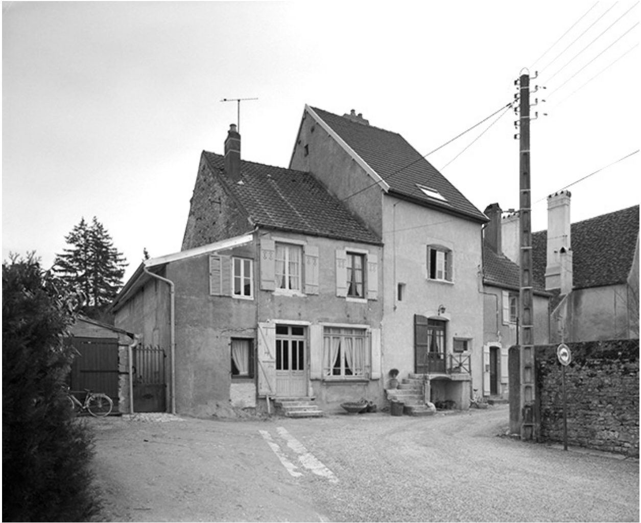
Maison située rue Sainte-Anne : vue d'ensemble.
