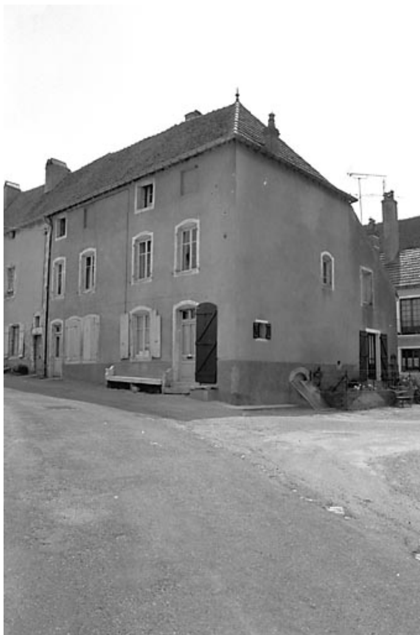
Maison située 7 rue Saint-Hilaire : vue d'ensemble.
