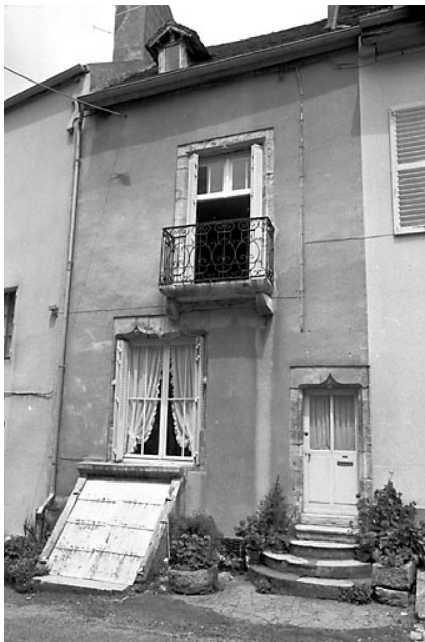
Maison située 6 rue Saint-Hilaire : façade antérieure.
