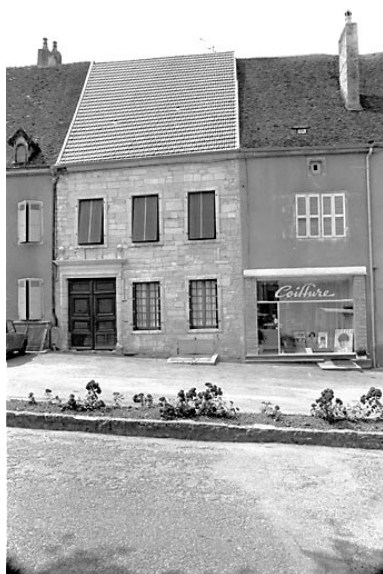
Maison située 10 Grande Rue : façade antérieure. Phot. Bernard Lardière IVR43_19817000847Z
