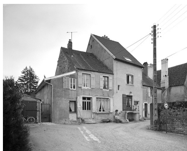
Maison située rue Sainte-Anne : vue d'ensemble. Phot. Yves Sancey IVR43_19857000034V
