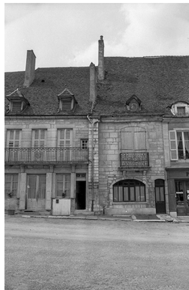
Maison située 28 Grande Rue : vue d'ensemble. Phot. Bernard Lardière IVR43_19817000833Z
