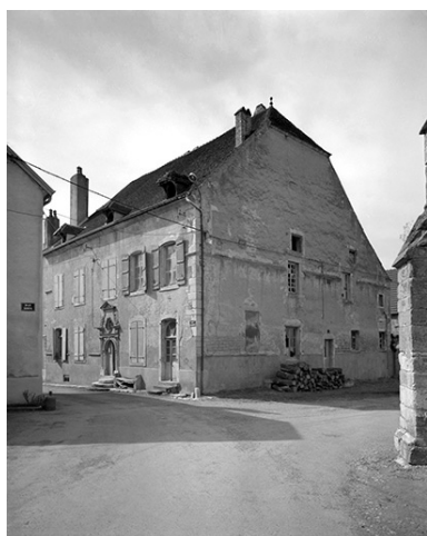
Maison située 1 rue de Granvelle : vue d'ensemble. Phot. Yves Sancey IVR43_19857000036V
