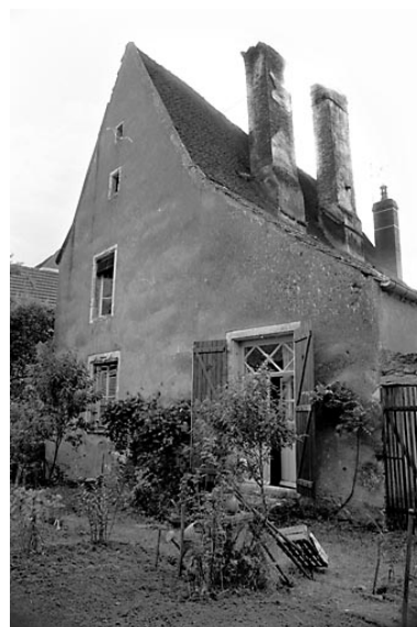
Maison située rue Sainte-Anne : vue d'ensemble. Phot. Bernard Lardière IVR43_19817000826Z
