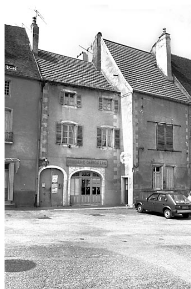
Maison située 6 Grande Rue : vue d'ensemble. Phot. Bernard Lardière IVR43_19817000852Z
