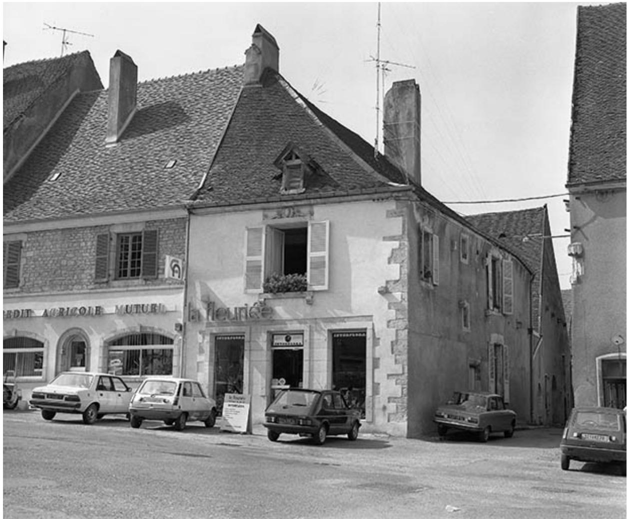
Ferme située rue Notre-Dame : vue d'ensemble.
