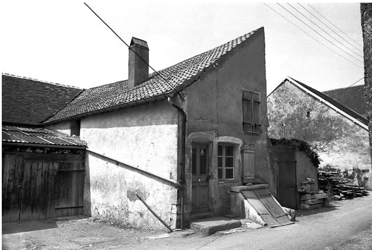
Maison située rue Granvelle : vue d'ensemble.
