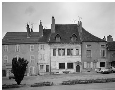
Maison située 23 Grande Rue : vue d'ensemble. Phot. Yves Sancey IVR43_19857000028V
