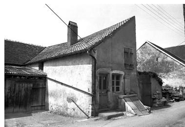
Maison située rue Granvelle : vue d'ensemble. Phot. Bernard Lardière IVR43_19817000785Z
