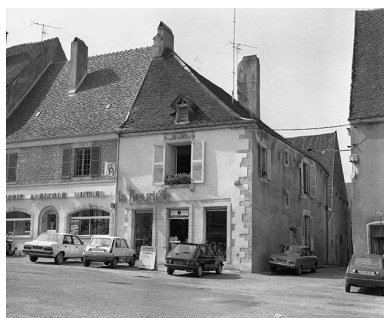
Ferme située rue Notre- Dame : vue d'ensemble. Phot. Bernard Lardière IVR43_19817000840X
