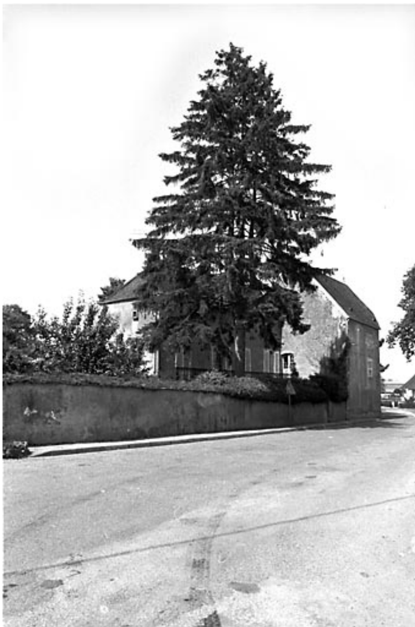
Maison située rue des Promenades : vue d'ensemble.
