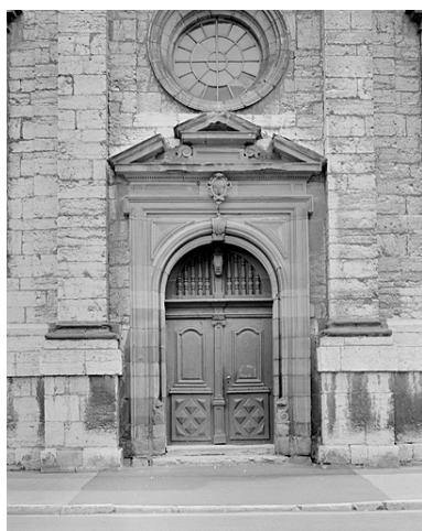
Portail ouest. Phot. Jérôme Mongreville IVR43_19872500738X
