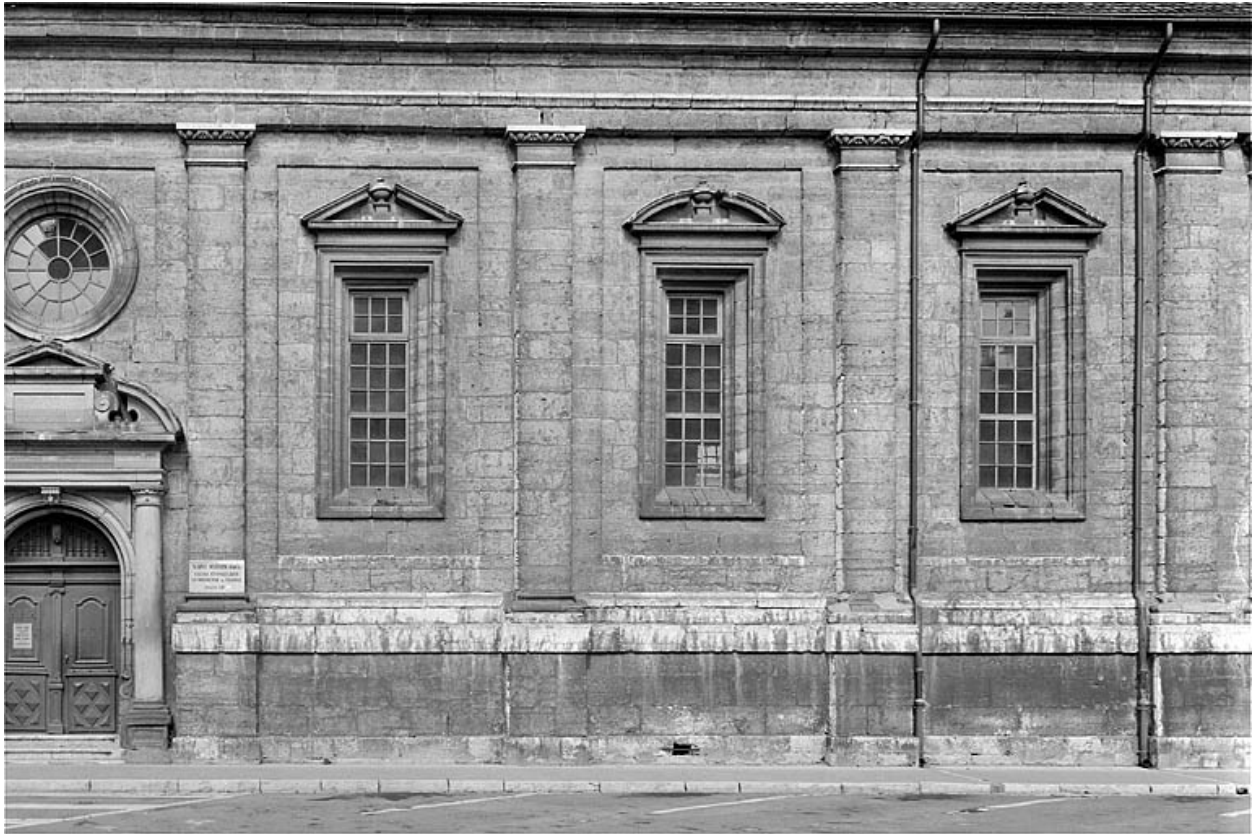
Façade sud, travées de droite.
