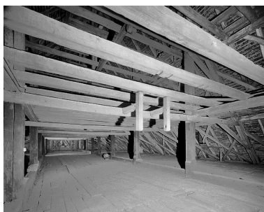
Charpente, vue d'ensemble vers l'est. Phot. Jérôme Mongreville IVR43_19882500052V
