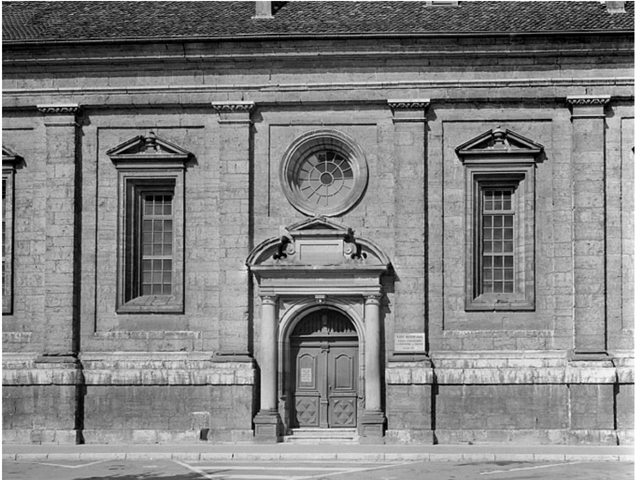
Façade sud, travées centrales.
