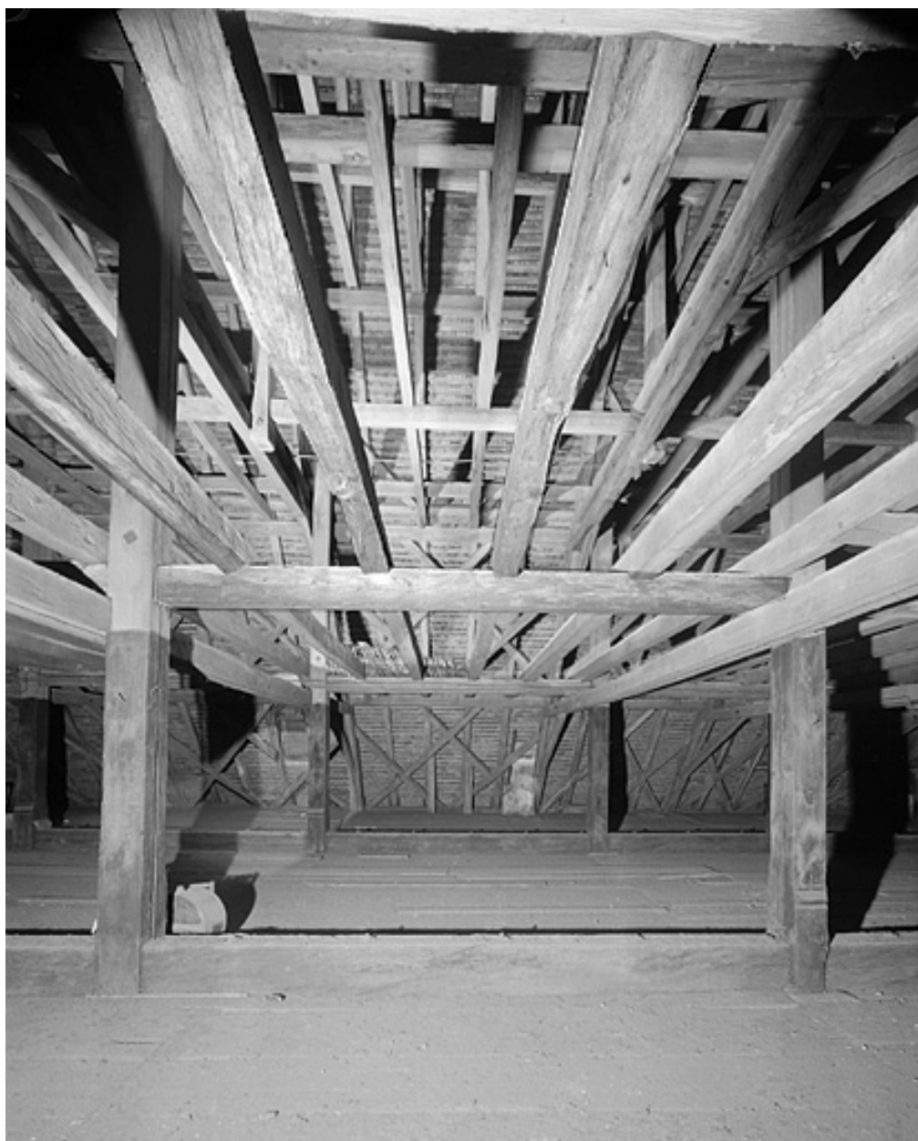
Charpente, vue latérale.
