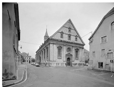
Façades ouest et nord. Phot. Jérôme Mongreville IVR43_19872501157V
