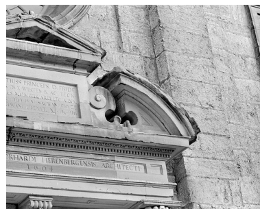
Portail sud, détail. Phot. Jérôme Mongreville IVR43_19872500643X
