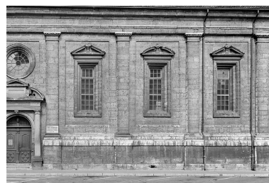
Façade sud, travées de droite. Phot. Jérôme Mongreville IVR43_19872501100V
