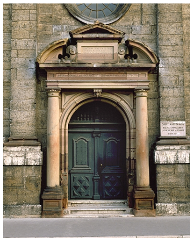
Portail sud. Phot. Jérôme Mongreville IVR43_19872500641XA
