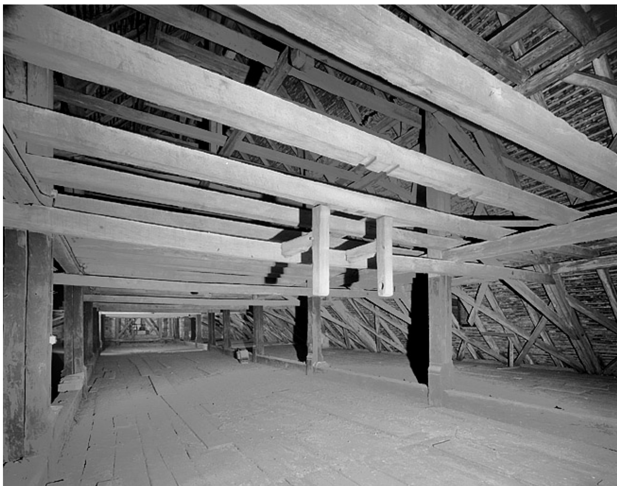
Charpente, vue d'ensemble vers l'est.
