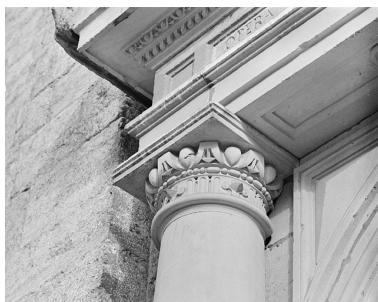
Portail sud, détail. Phot. Jérôme Mongreville IVR43_19872500642X
