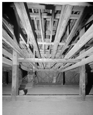
Charpente, vue latérale. Phot. Jérôme Mongreville IVR43_19882500053V
