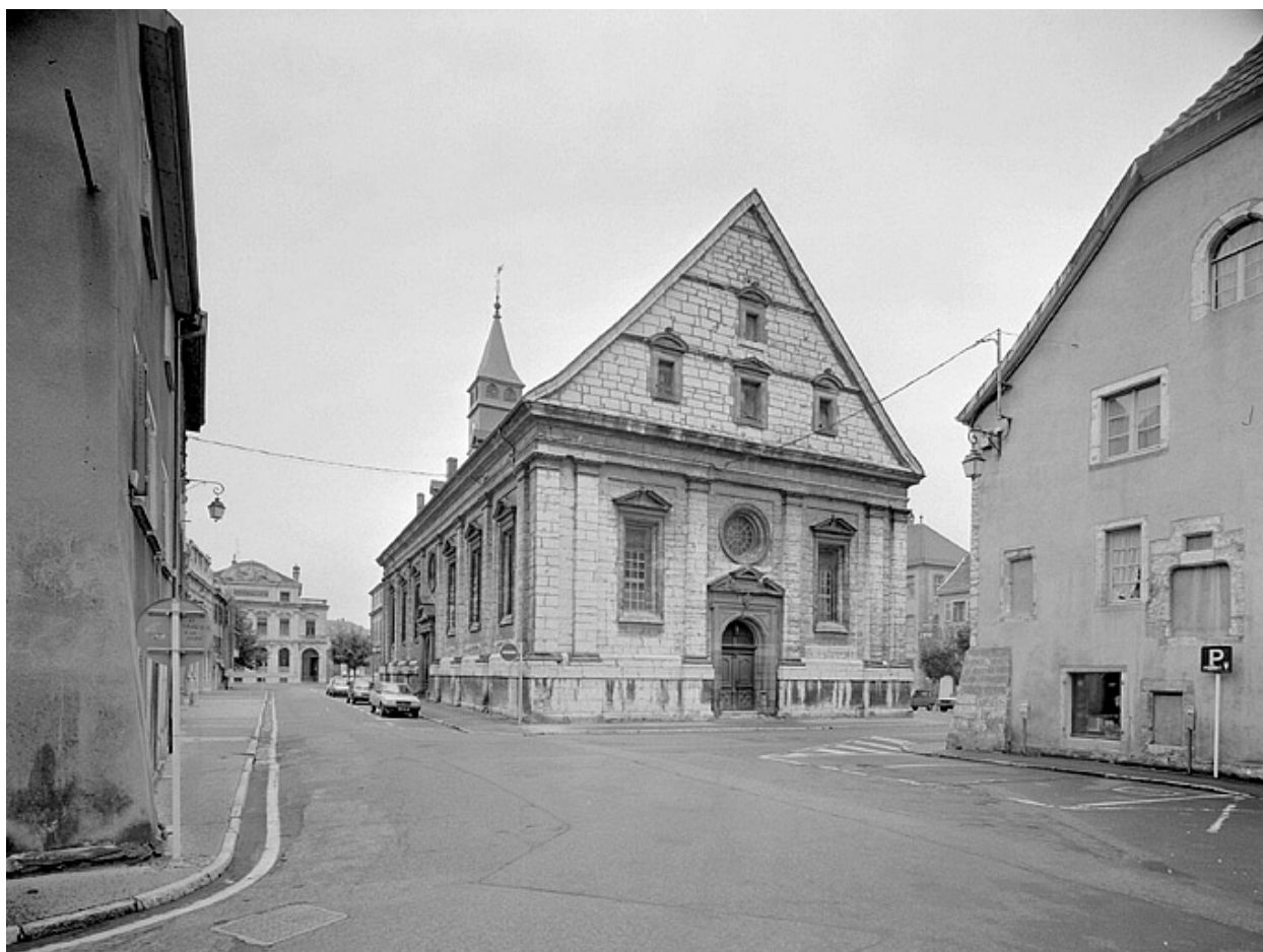
Façades ouest et nord.
