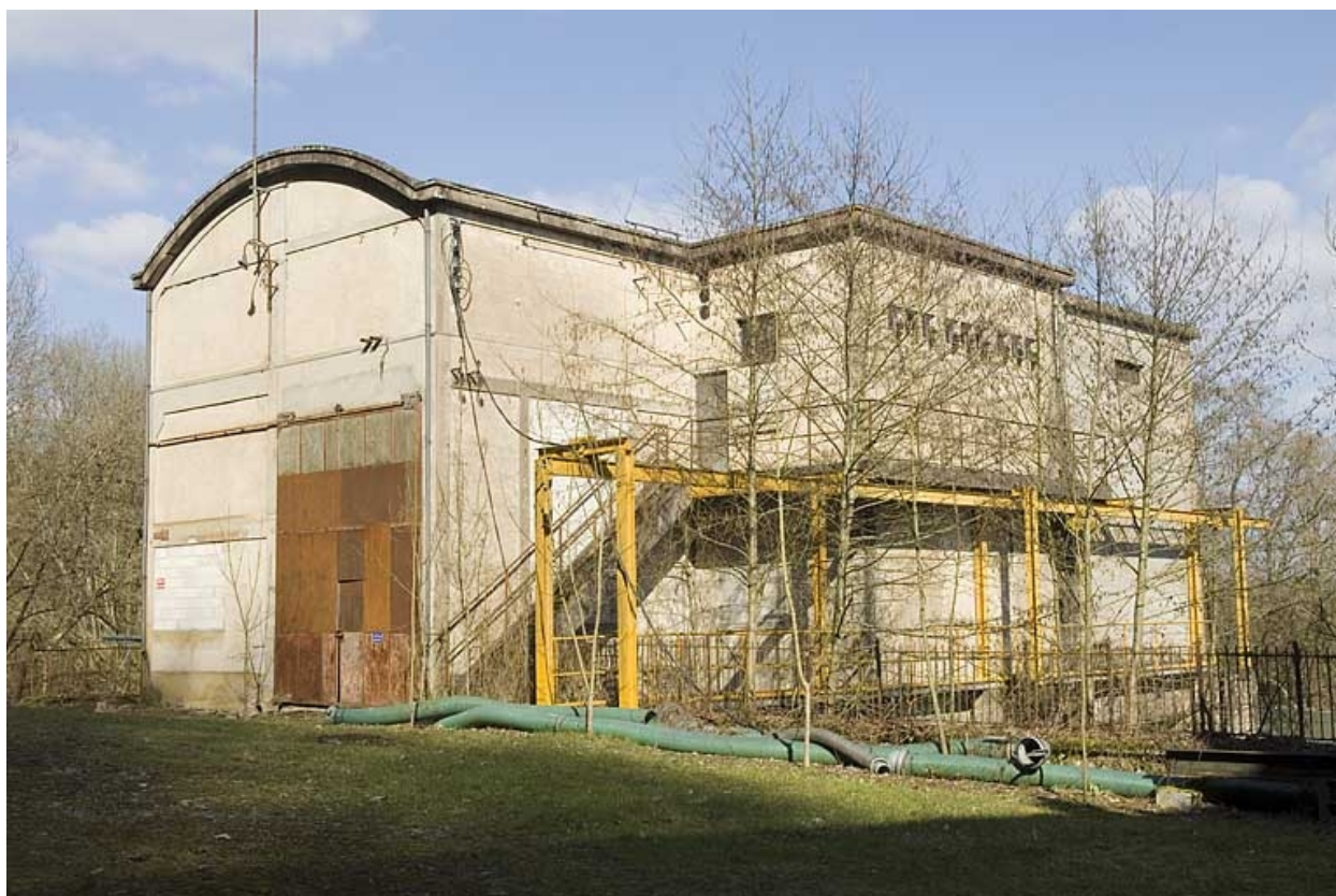
La centrale hydroélectrique vue de trois quarts.
