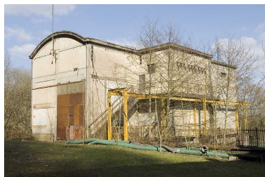
La centrale hydroélectrique vue de trois quarts.
