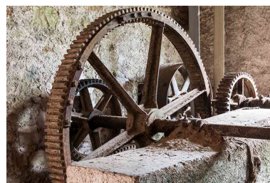
Détail des roues dentées. Phot. Jérôme Mongreville IVR43_20152501808NUC4A
