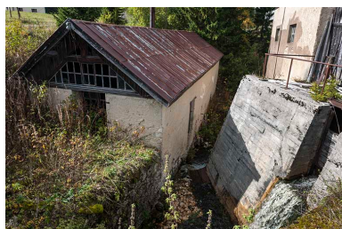
Salle de la machine à vapeur. Phot. Jérôme Mongreville IVR43_20152501799NUC4A
