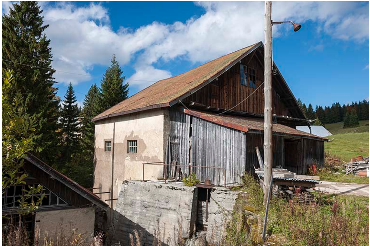
Atelier de scierie vu depuis le sud.
