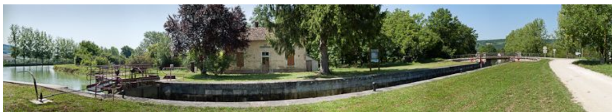
Vue d'ensemble du site d'écluse.
