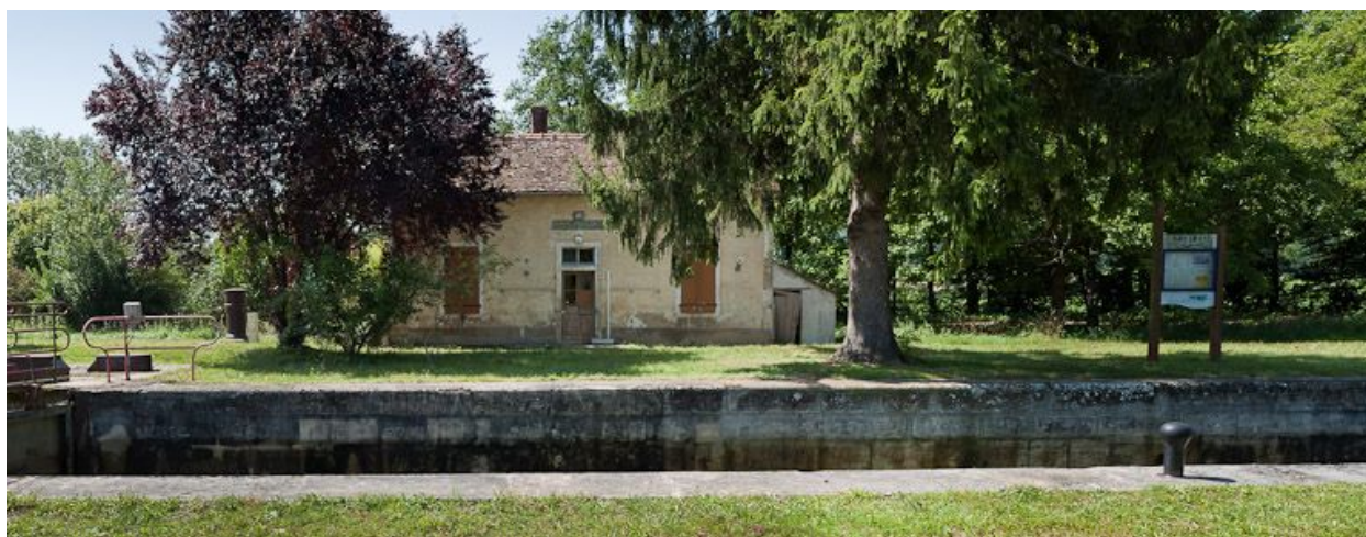
Vue de face de la maison éclusière.
