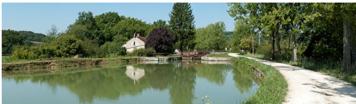
Vue du site d'écluse depuis l'amont.
