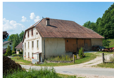
Façades postérieure et latérale droite.
