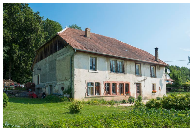
Façades antérieure et latérale gauche.
