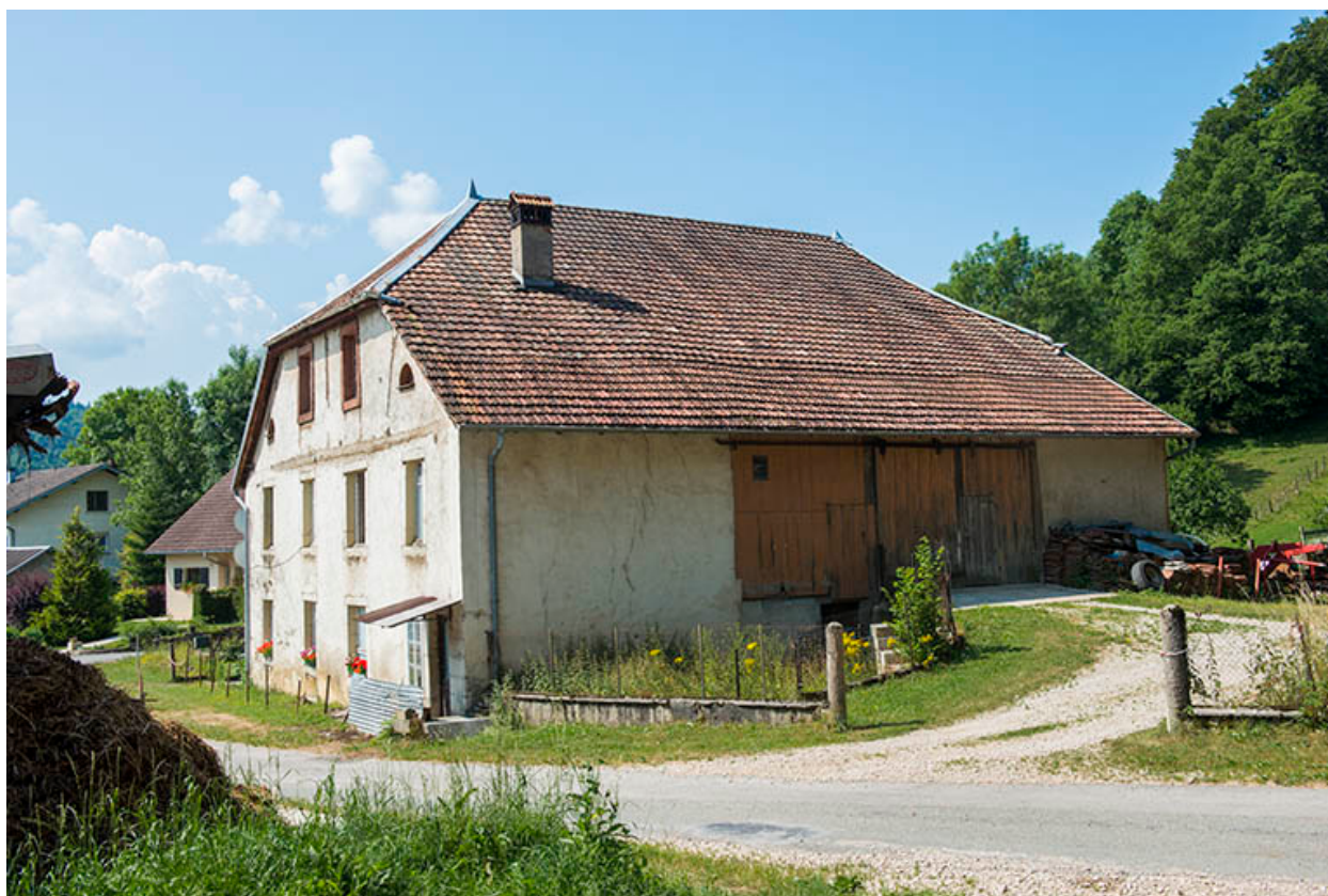
Façades postérieure et latérale droite.
