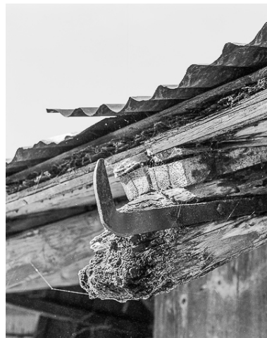
Détail : crochet en fer qui soutenait le chéneau en bois. Phot. Dominique Dominguez IVR43_19792500974X
