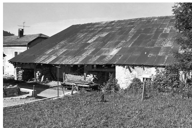
Mur goutterot et toiture. Phot. Dominique Dominguez IVR43_19792500972X
