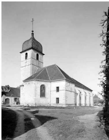
Façade latérale nord et chevet. Phot. Yves Sancey IVR43_19773900186V
