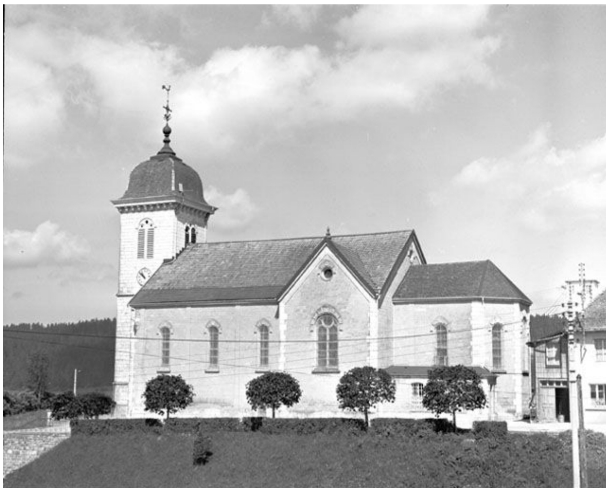
Extérieur : façade droite.
