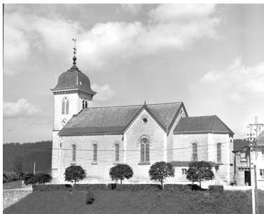
Extérieur : façade droite. Phot. Yves Sancey IVR43_19792500663X
