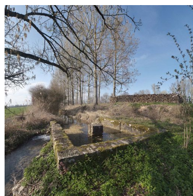
Bassin maçonné recevant les eaux du contre-fossé et celles de l'aqueduc passant sous l'écluse. Phot. Thierry Kuntz IVR26_20112103181NUC4A
