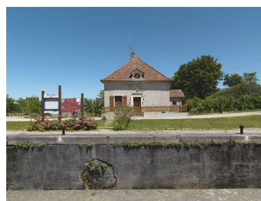
Maison éclusière vue de face. Phot. Thierry Kuntz IVR26_20112103163NUC4A
