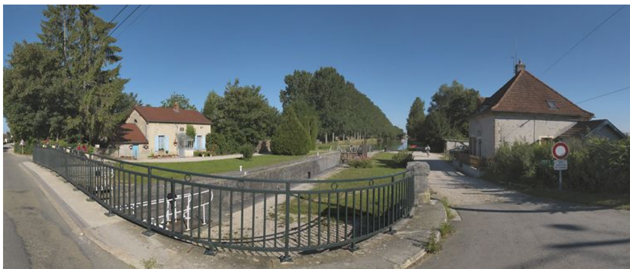
Vue d'ensemble du site, prise d'aval.
