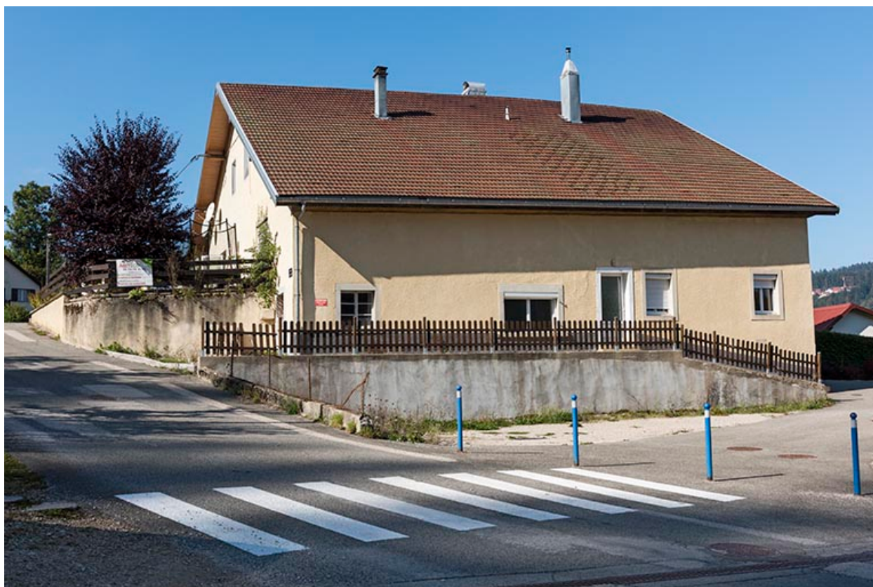
Façade latérale droite, de trois quarts gauche.
