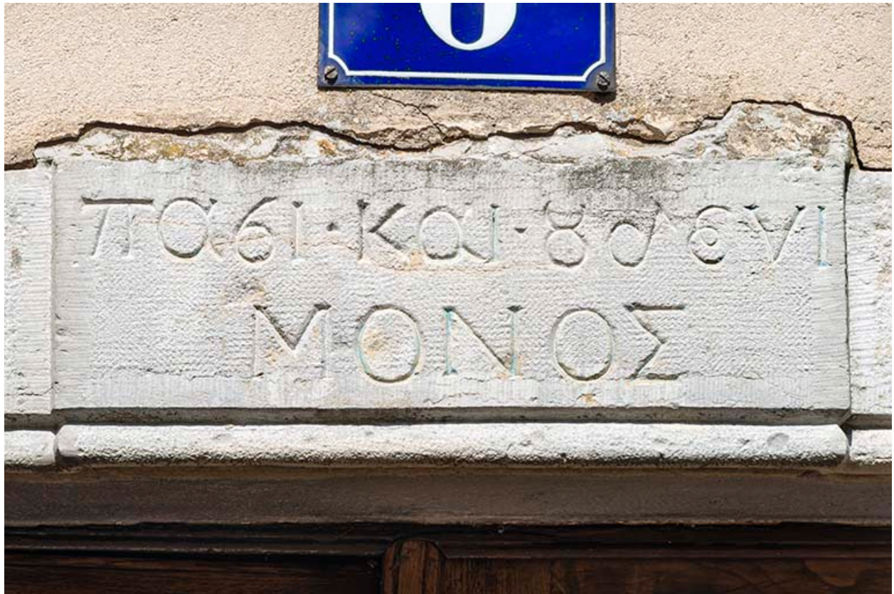
Façade sur rue. Linteau gravé.
