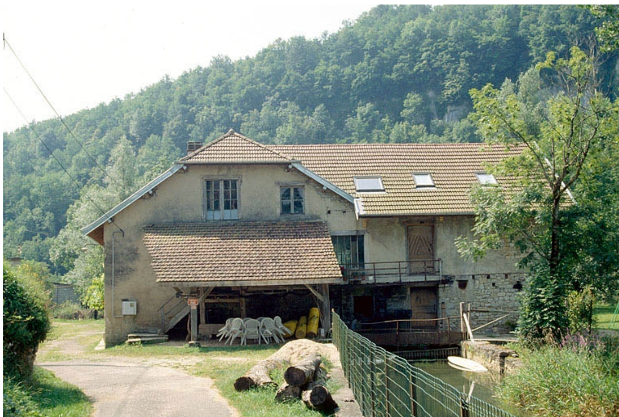
Moulin et tournerie, vus du nord.
