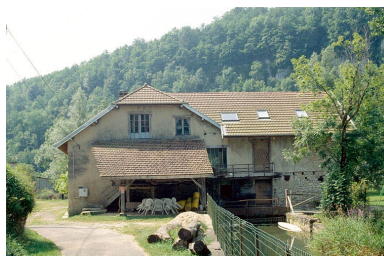
Moulin et tournerie, vus du nord.
