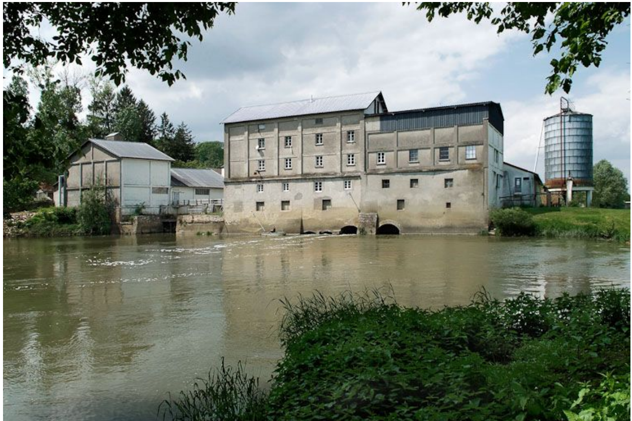
Le moulin : vue d'ensemble d'aval.
