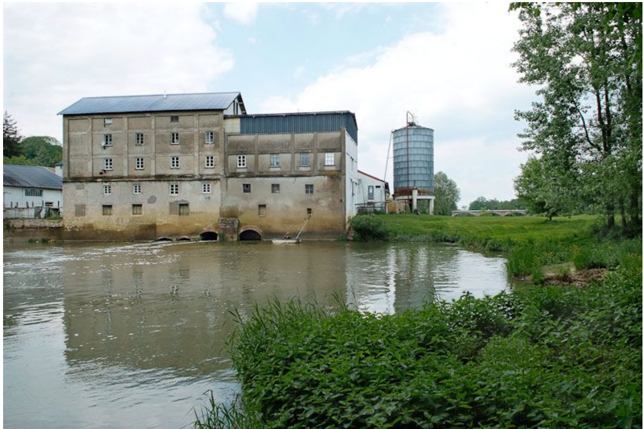
Le moulin vu d'aval.
