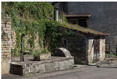
Vue depuis le haut de la rue. Phot. Jérôme Mongreville IVR43_20177001253NUC4A
