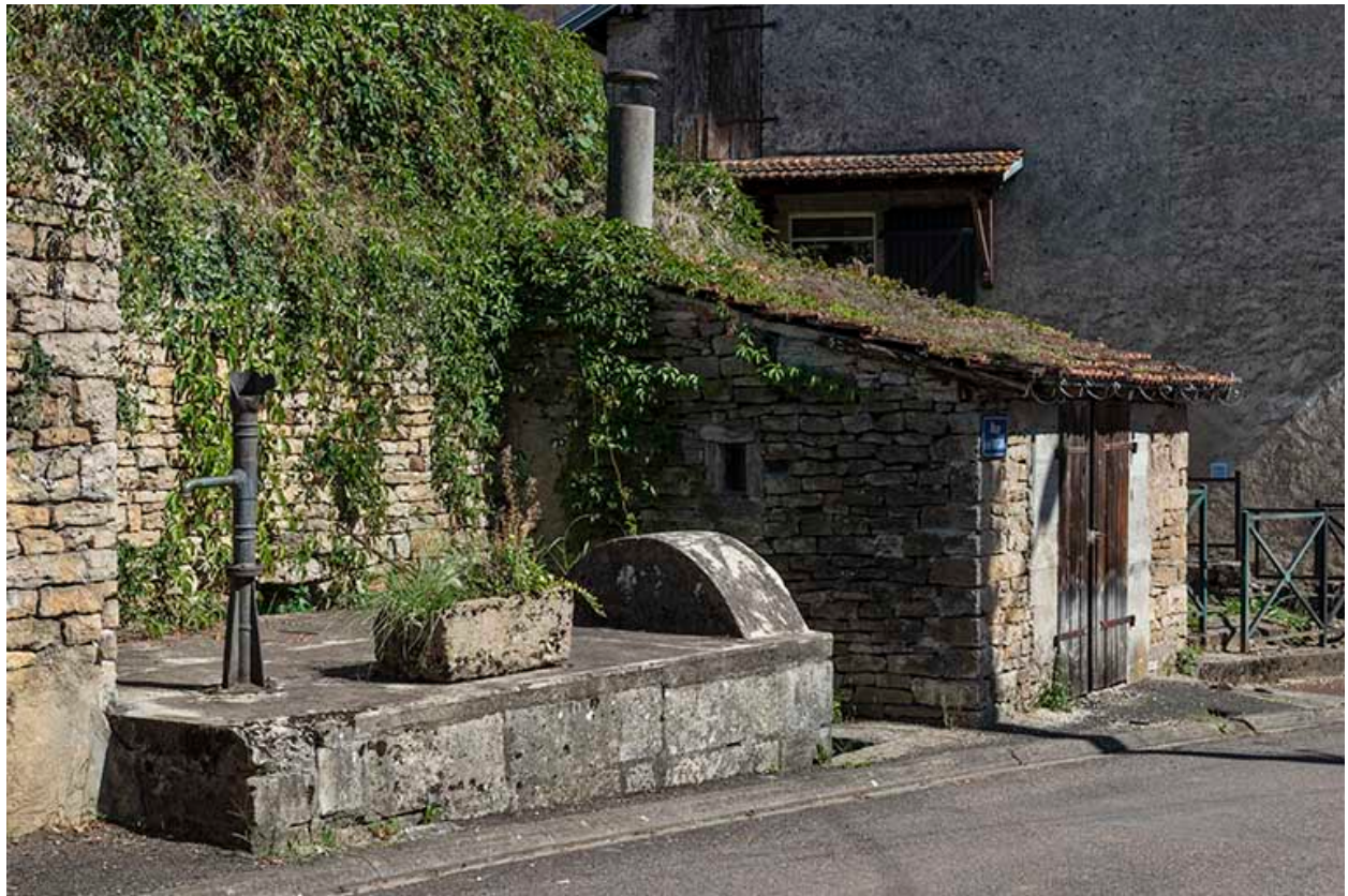
Vue depuis le haut de la rue.
