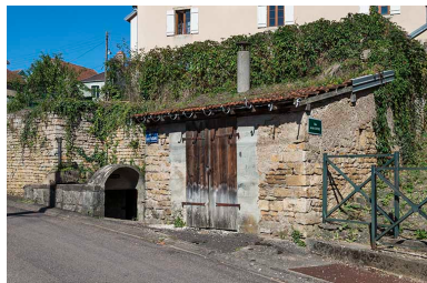
Vue générale. Phot. Jérôme Mongreville IVR43_20177001251NUC4A
