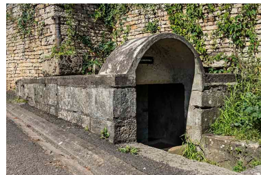
Vue sur l'entrée du puisard avec la couverture en béton armé. Phot. Jérôme Mongreville IVR43_20177001252NUC4A
