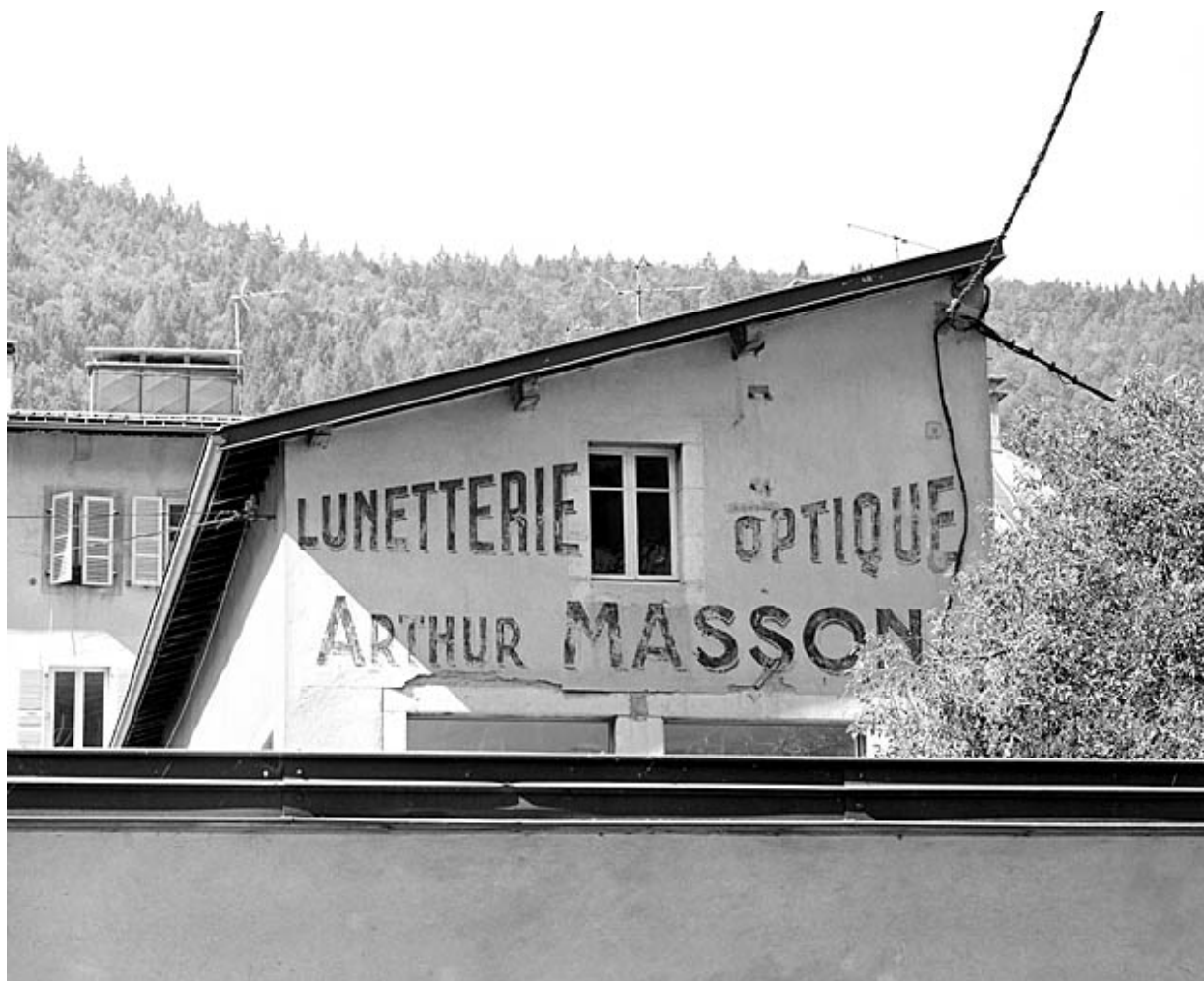
Ateliers : inscription sur le mur pignon oriental.
