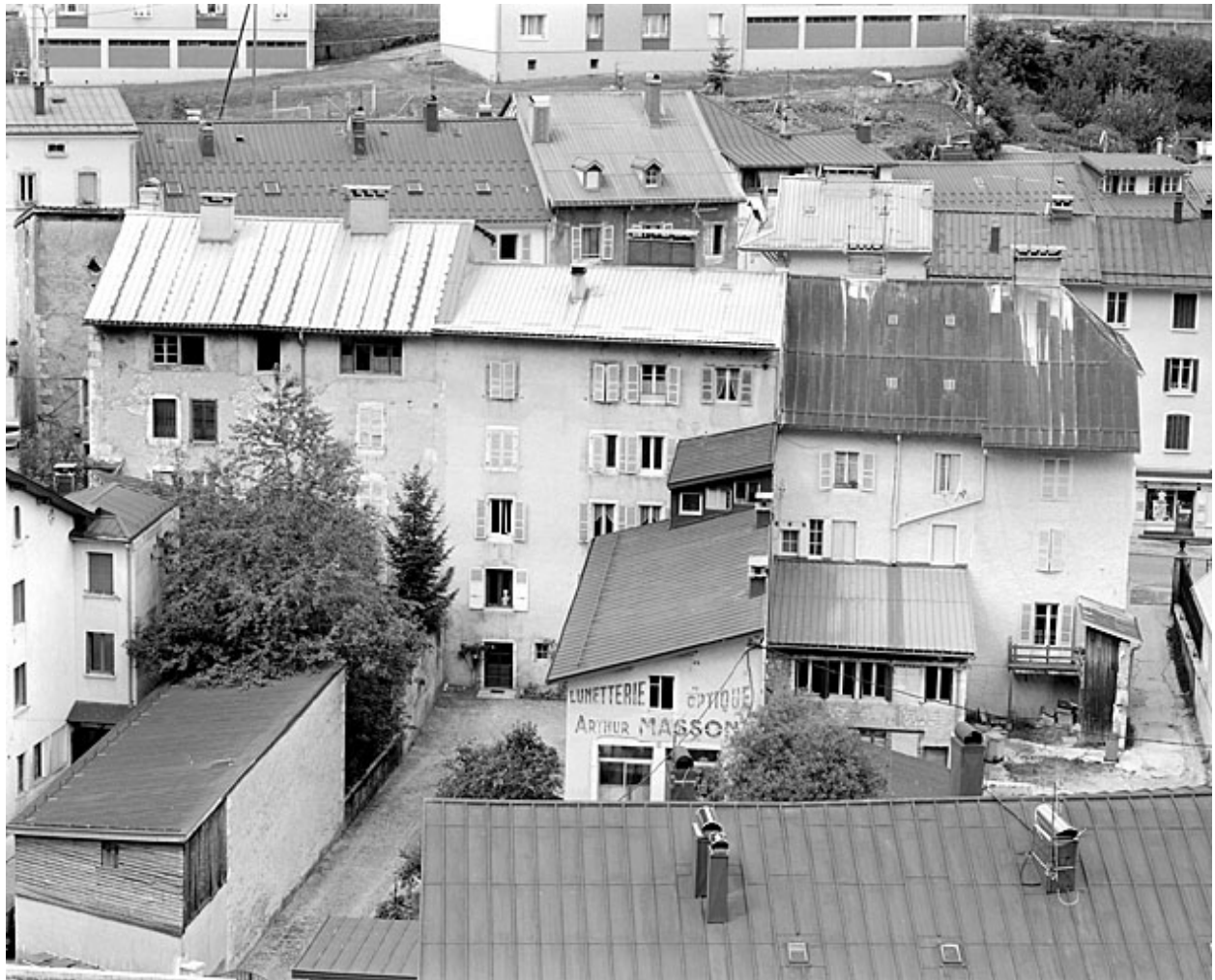
Vue plongeante sur la façade postérieure.
