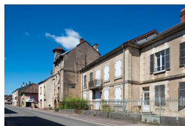
Côté est, maisons n ° 27-31, vue vers le nord. Phot. Jérôme Mongreville IVR43_20187000433NUC4A
