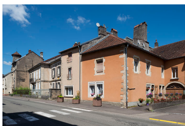
Côté est, maisons n ° 29-35, vue vers le nord. Phot. Jérôme Mongreville IVR43_20187000440NUC4A
