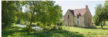
Vue d'ensemble du site abandonné. Phot. Pierre-Marie Barbe-Richaud IVR26_20138900151NUC4AQ
