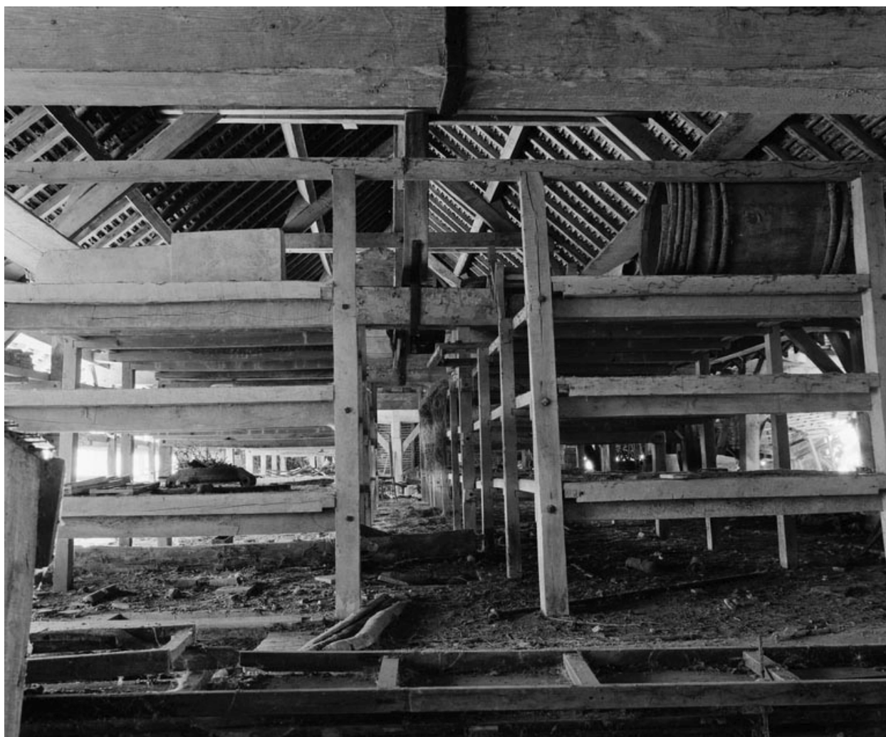
Vue des séchoirs, depuis l'extrémité est.
