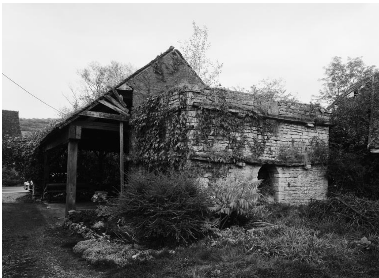
Bâtiment du four et four : élévation postérieure.
