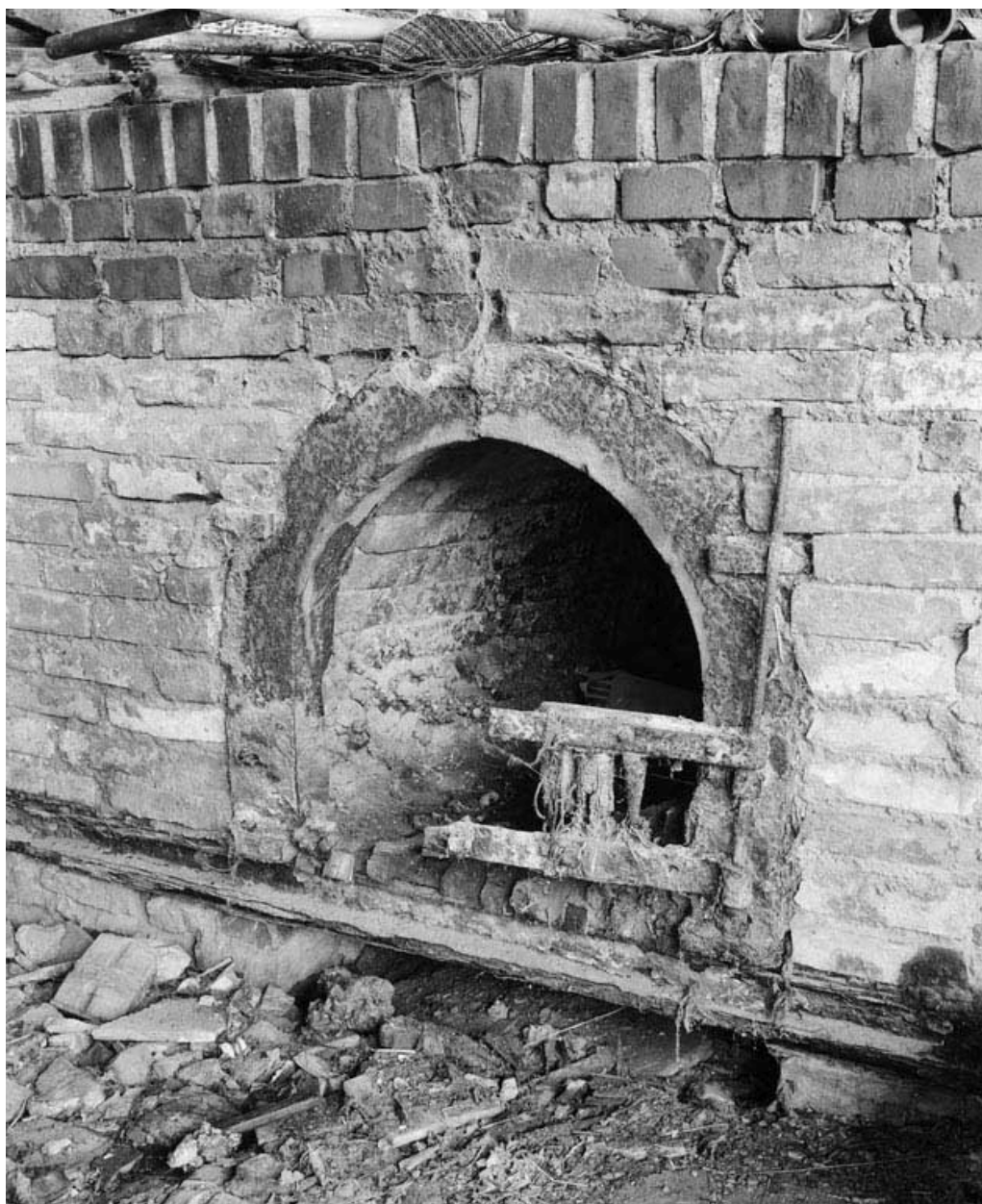
Détail du four : bouche d'enfournement du bois.
