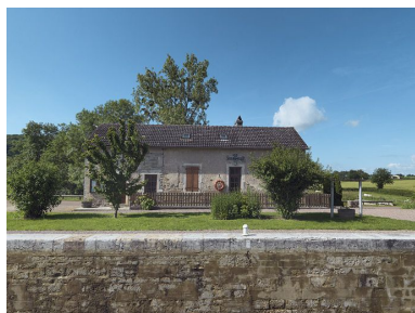
Maison éclusière de face. Phot. Thierry Kuntz IVR26_20122102181NUC4A
