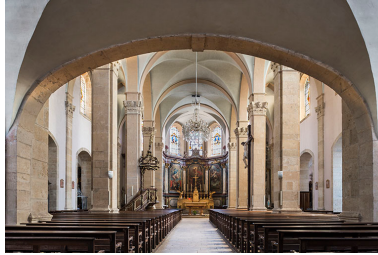
La nef et le choeur. Phot. Jérôme Mongreville IVR43_20187000559NUC4A
