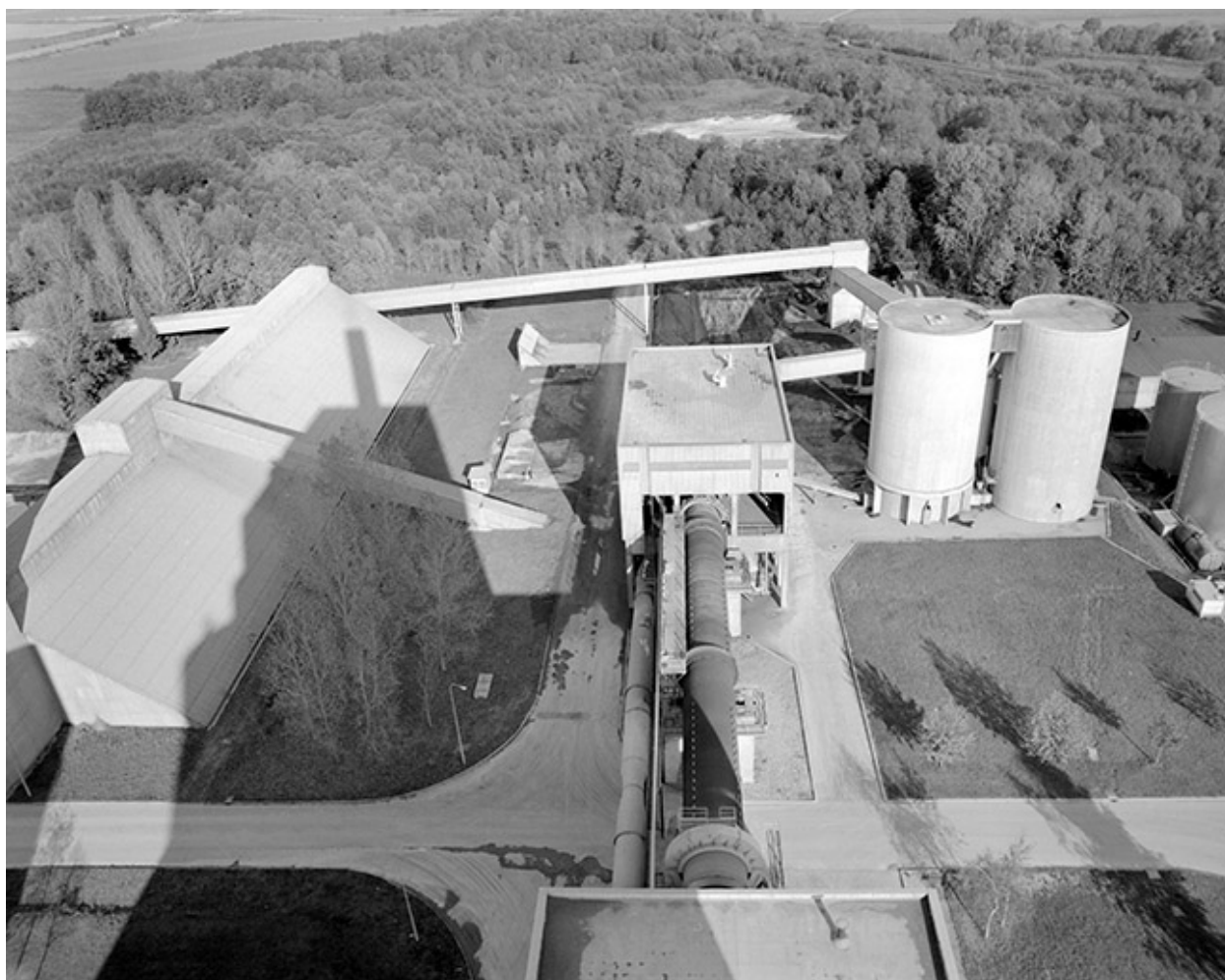
Stockage clinkers (D) et four rotatif, depuis le haut des silos.
