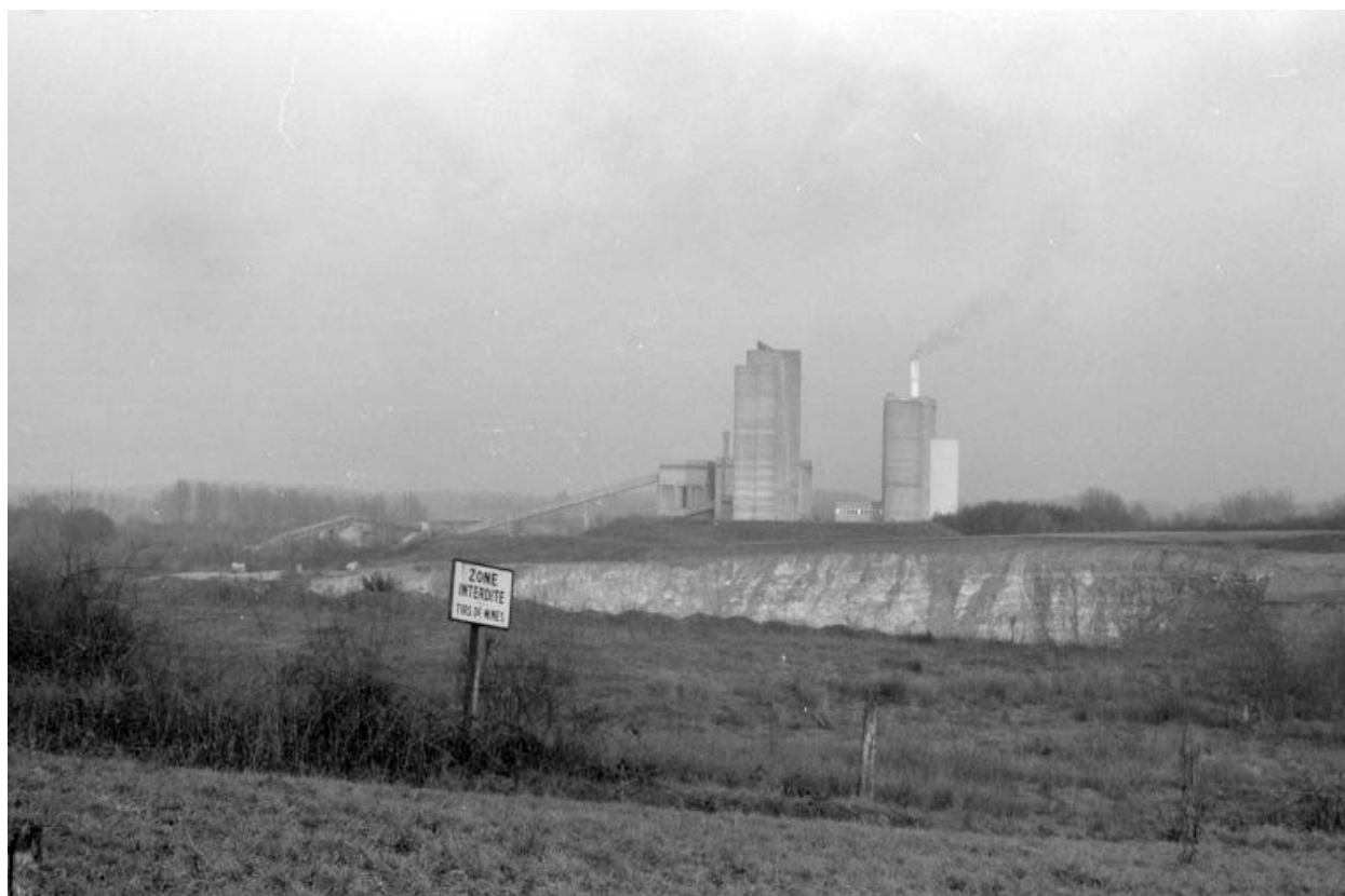
Vue d'ensemble, depuis l'ouest.
