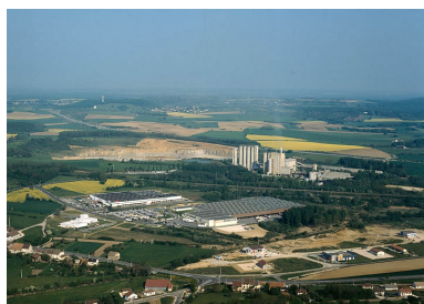
Vue aérienne, depuis le sud-est.
