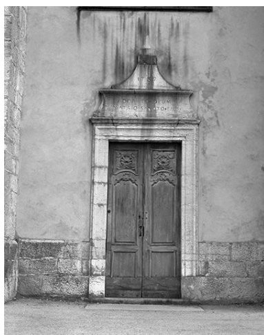
Porte d'entrée latérale. Phot. Yves Sancey IVR43_19782500669X
