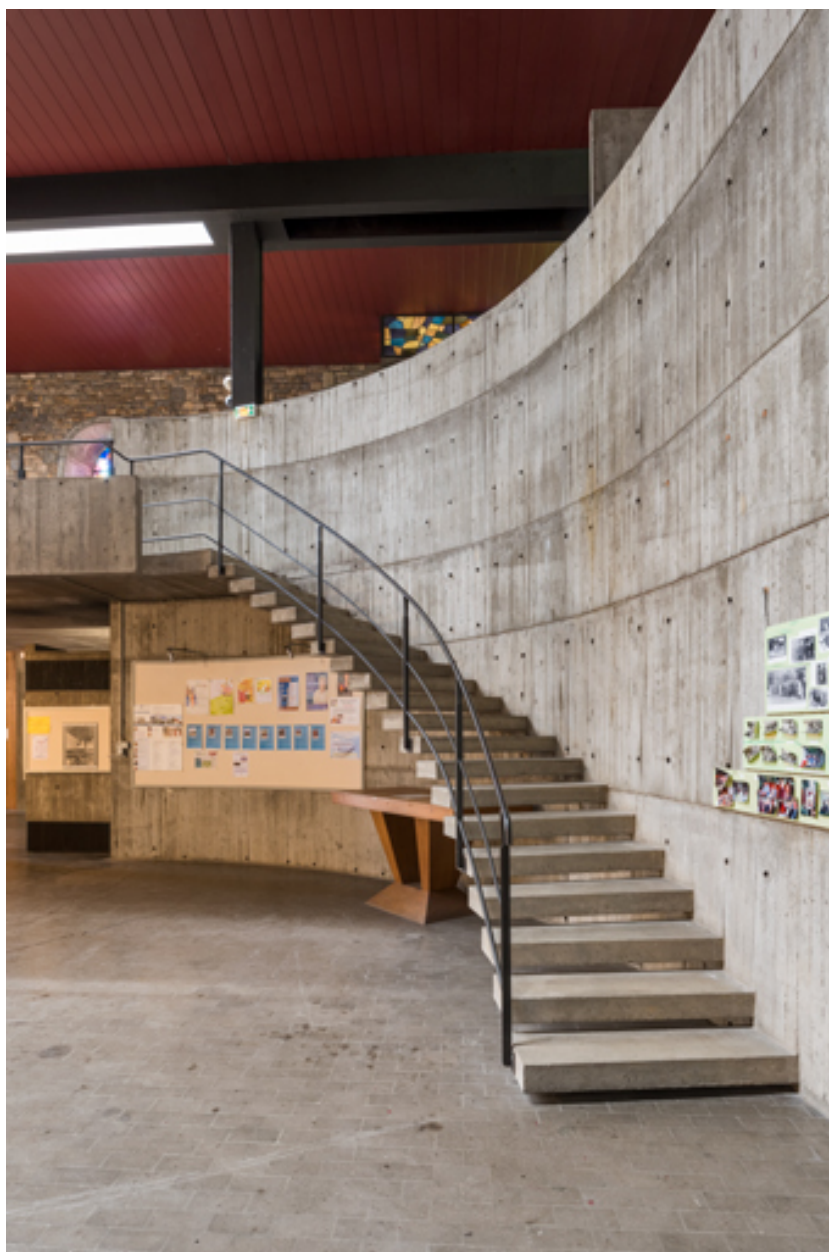
Escalier courbe donnant accès à la tribune sud.
