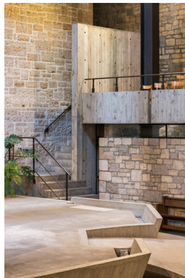
Escalier d'accès à la tribune est. Phot. Pierre-Marie Barbe-Richaud IVR43_20222500362NUC4A
