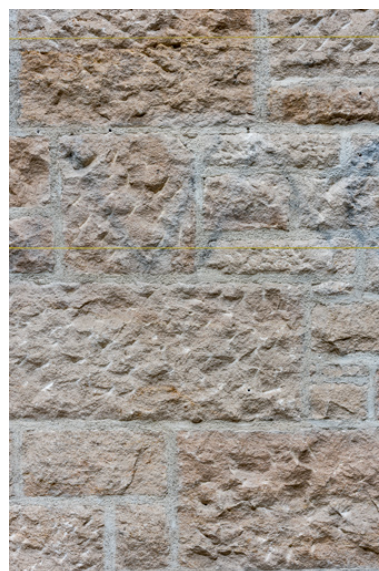
Maçonnerie du mur du chœur en appareil assisé. Détail. Phot. Pierre-Marie Barbe-Richaud IVR43_20222500379NUC4A
