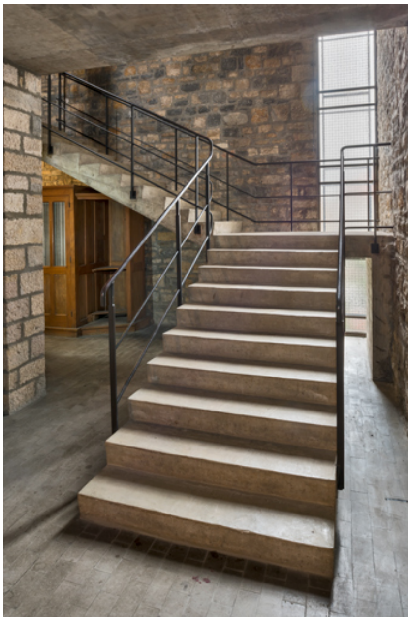
Escalier d'accès à la tribune sud.
