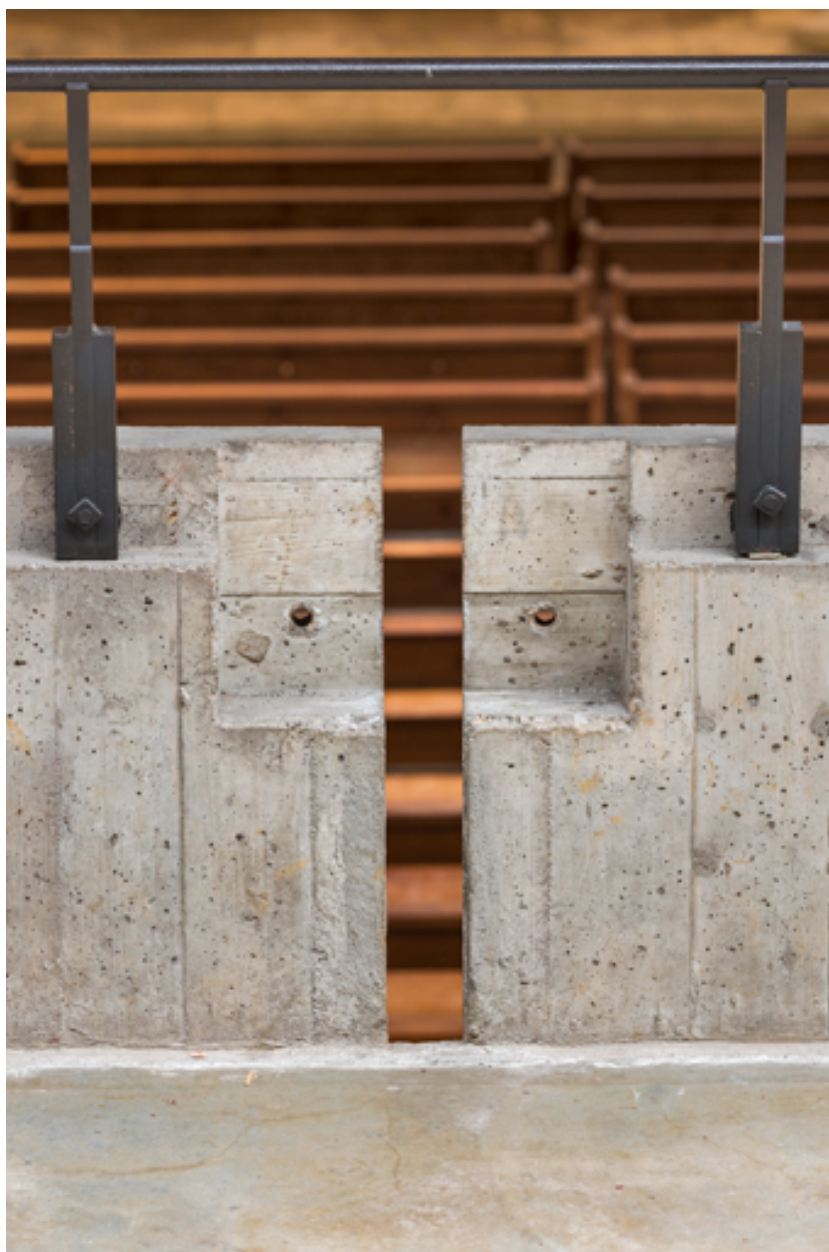
Garde-corps de la tribune sud. Détail.
