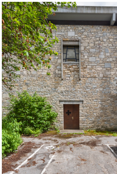
Porte extérieure donnant accès au dépositaire surmontée d'une baie. Phot. Pierre-Marie Barbe-Richaud IVR43_20222500383NUC2A
