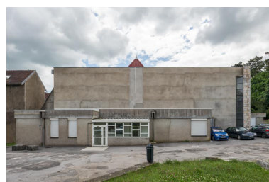
Façade postérieure, avec la sacristie et la salle de réunion. Phot. Pierre-Marie Barbe-Richaud IVR43_20222500137NUC4A
