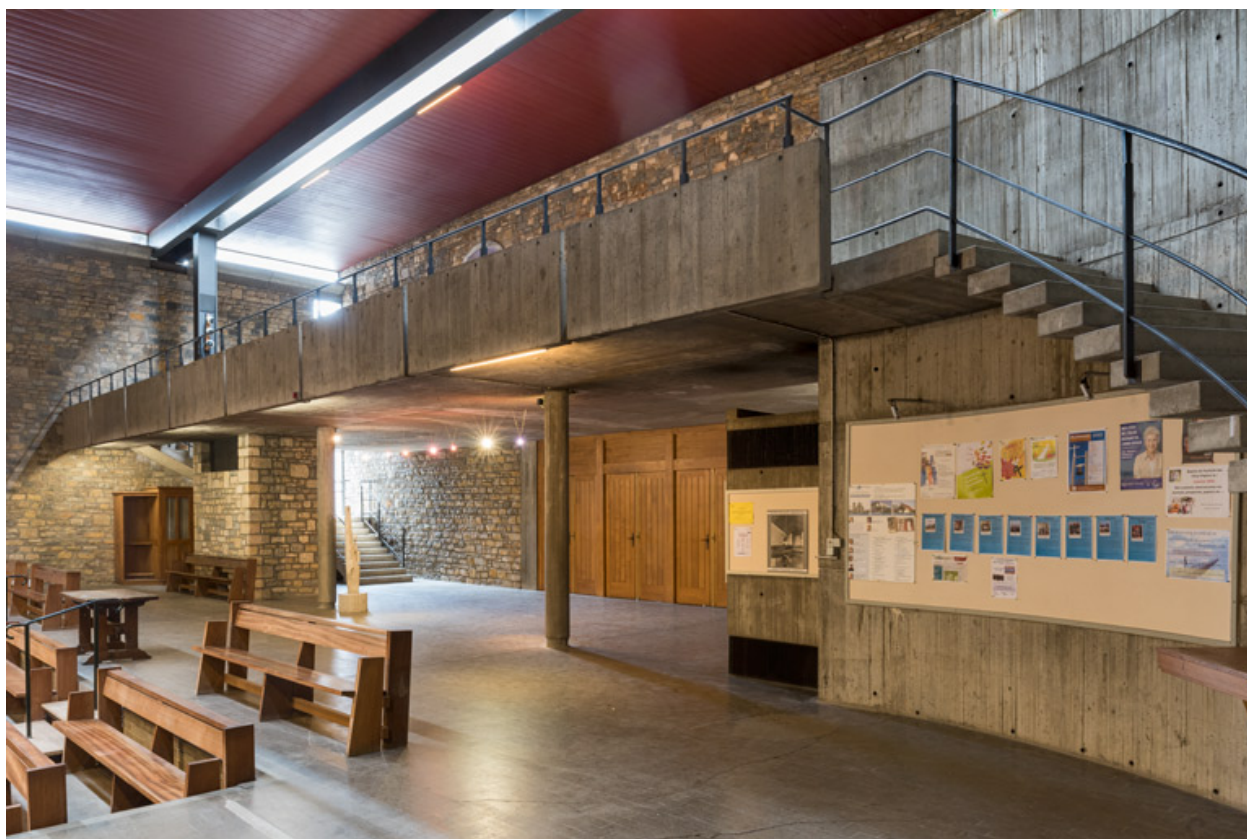
Tribune sud. Vue de trois quarts. En haut, l'une des quatre ouvertures zénithales.
