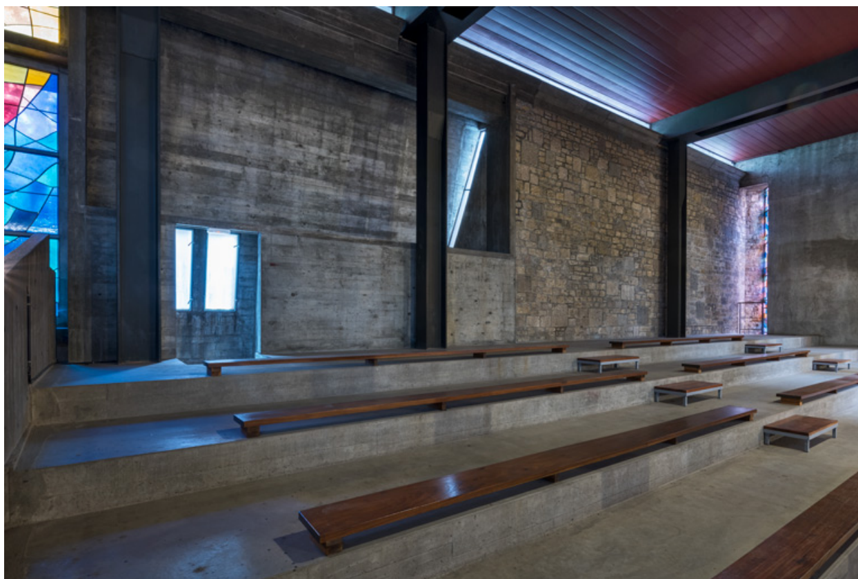
Tribune ouest. Vue en direction du mur ouest, de trois quarts.
