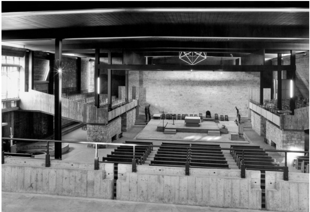
Vue intérieure depuis la tribune sud-ouest. Aménagement du chœur avant sa modification dans les années 1980.
