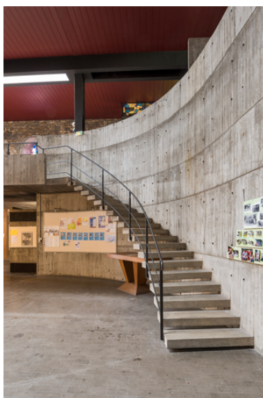
Escalier courbe donnant accès à la tribune sud. Phot. Pierre-Marie Barbe-Richaud IVR43_20222500366NUC4A
