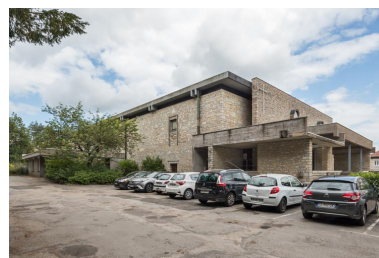
Façade latérale gauche. Vue de trois quarts. Phot. Pierre-Marie Barbe-Richaud IVR43_20222500140NUC4A
