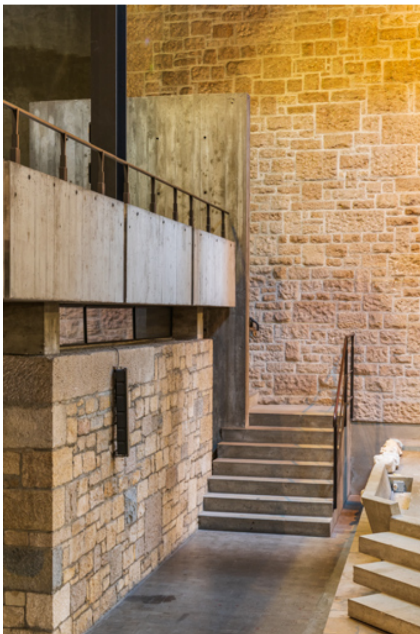
Escalier d'accès à la tribune ouest.
