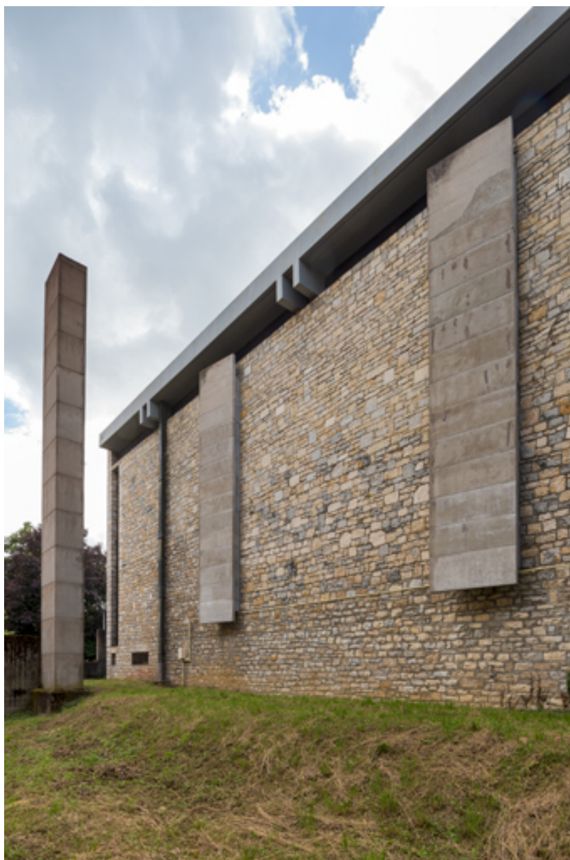
Façade latérale droite. Vue de trois quarts.
