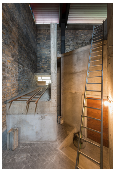
Accès intérieur au dépositoire. A gauche, le couvrement de l'escalier menant à la salle paroissiale Saint-Boniface. Phot. Pierre-Marie Barbe-Richaud IVR43_20222500377NUC4A
