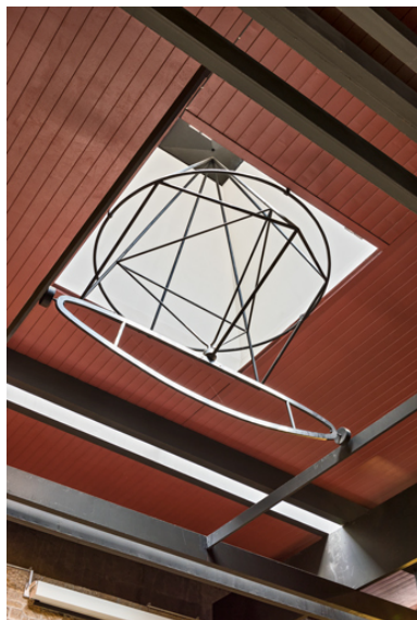
Ouverture zénithale et sa structure métallique au-dessus du chœur. Phot. Pierre-Marie Barbe-Richaud IVR43_20222500381NUC4A
