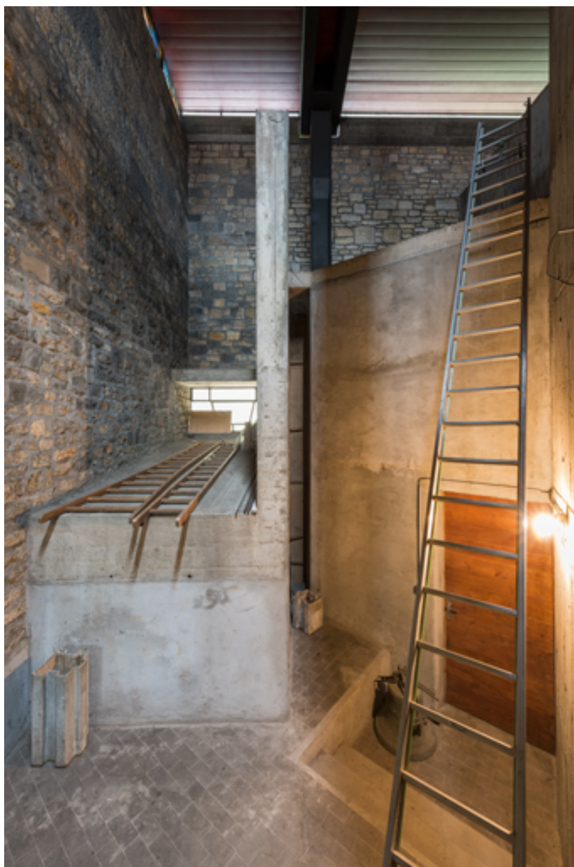
Accès intérieur au dépositaire. A gauche, le couvrement de l'escalier menant à la salle paroissiale Saint-Boniface.
