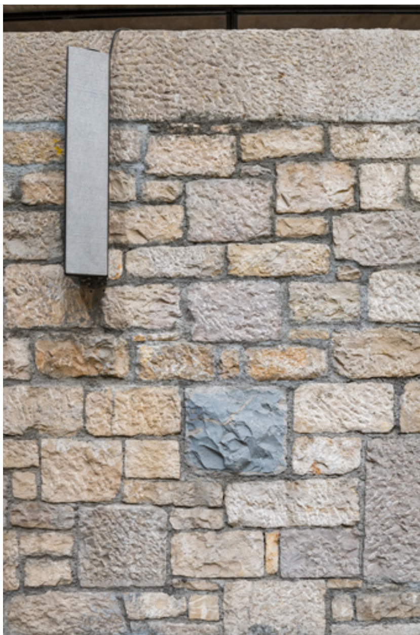
Maçonnerie du mur de la tribune ouest en appareil assisé. Détail.
