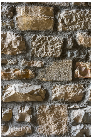
Maçonnerie en appareil assisé de moellons équarris. Détail du mur ouest, dans la chapelle de semaine. Au centre, une pierre de réemploi. Phot. Pierre-Marie Barbe-Richaud IVR43_20222500378NUC4A
