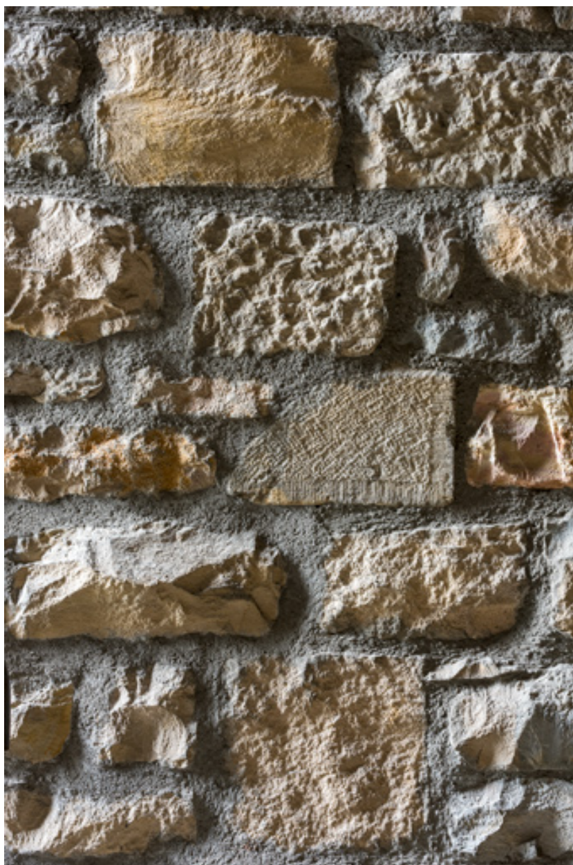
Maçonnerie en appareil assisé de moellons équarris. Détail du mur ouest, dans la chapelle de semaine. Au centre, une pierre de réemploi.
