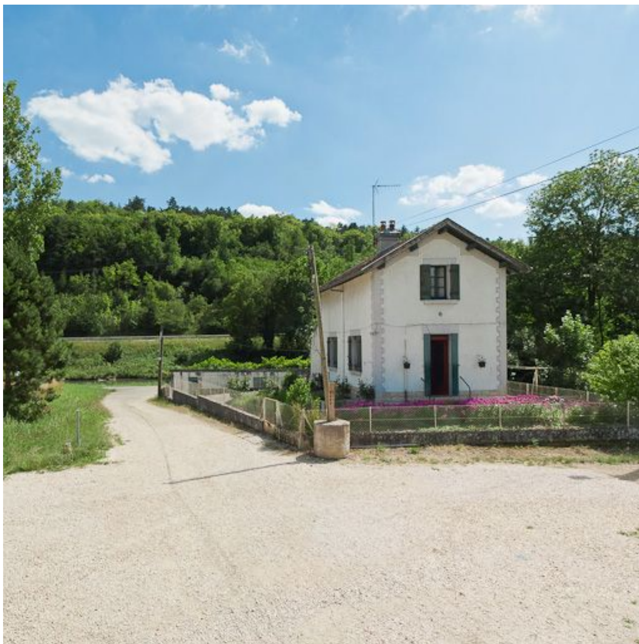
Vue de la maison de garde-barrière.
