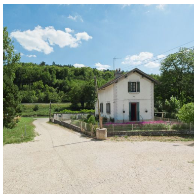
Vue de la maison de garde-barrière. Phot. Pierre-Marie Barbe-Richaud IVR26_20112103594NUC2AQ
