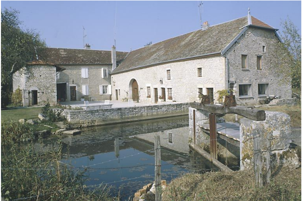
Vue d'ensemble des bâtiments.
