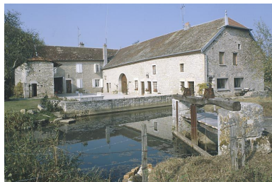
Vue d'ensemble des bâtiments.
