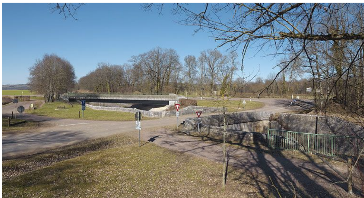
Vue d'ensemble des deux ponts.
