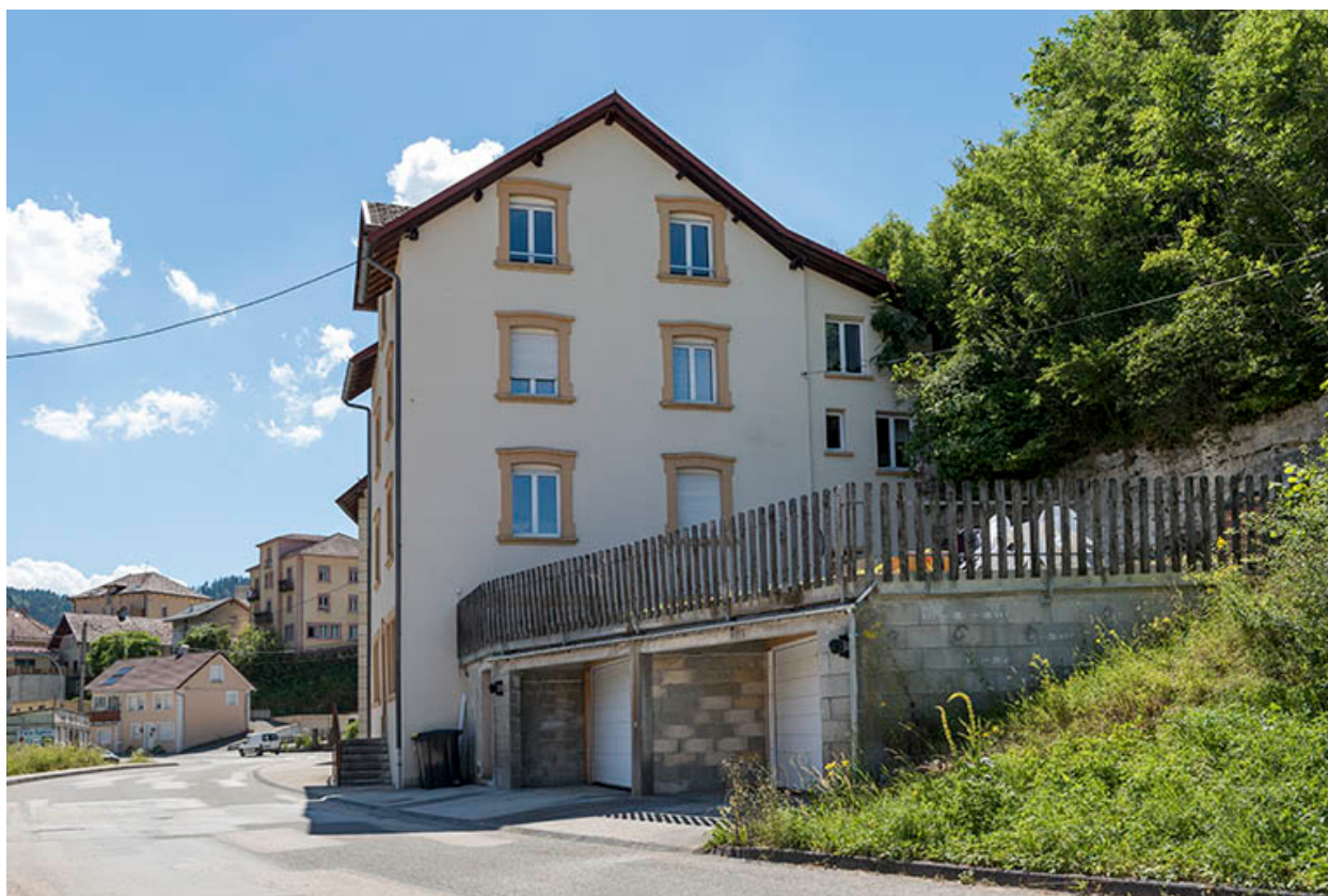
Façade latérale droite.
