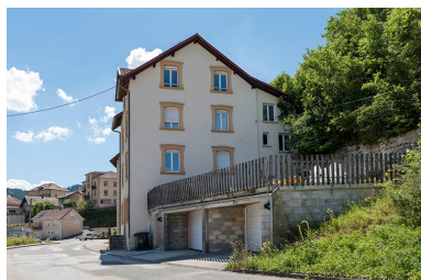
Façade latérale droite. Phot. Sonia Dourlot IVR43_20162500961NUC4A
